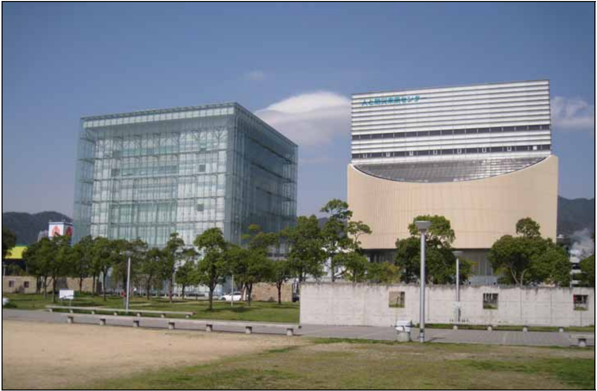
圖 6、人與防災未來中心大樓 (右為東館，左棟為西館)
