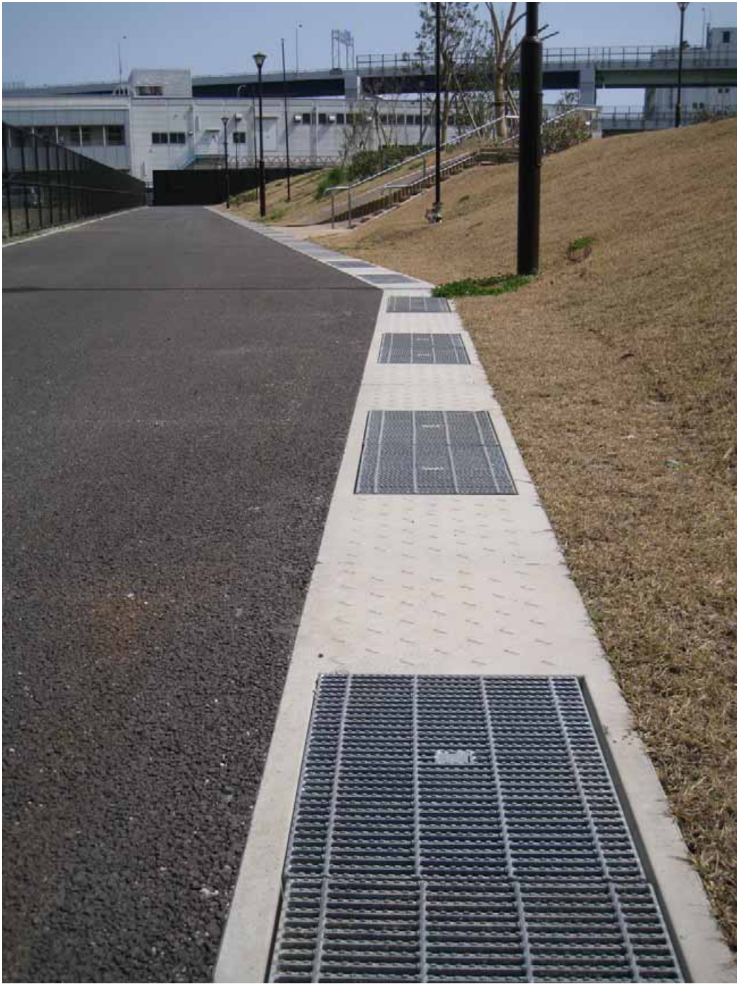
圖 117、神戶震災復興紀念公園 施工精準之道路鋪面與水溝泥作
