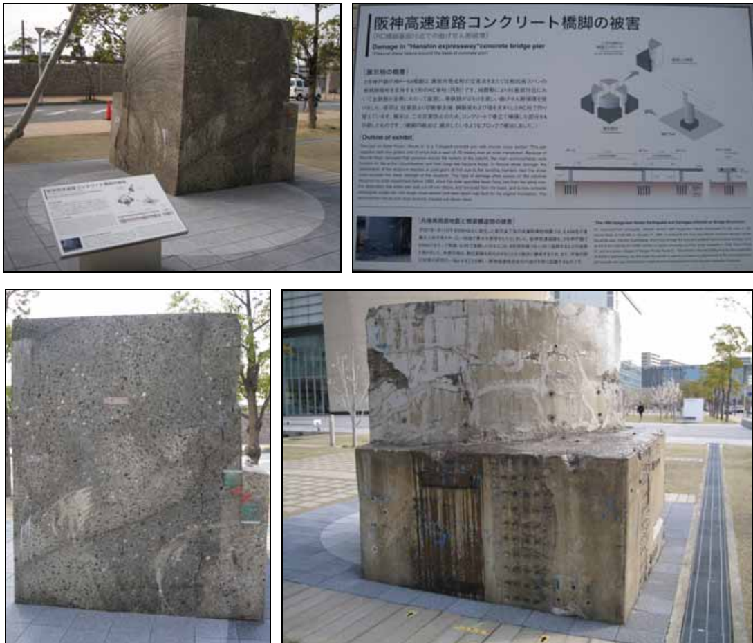
圖 11、人與防災未來中心戶外損壞高架道路橋墩實物展示
