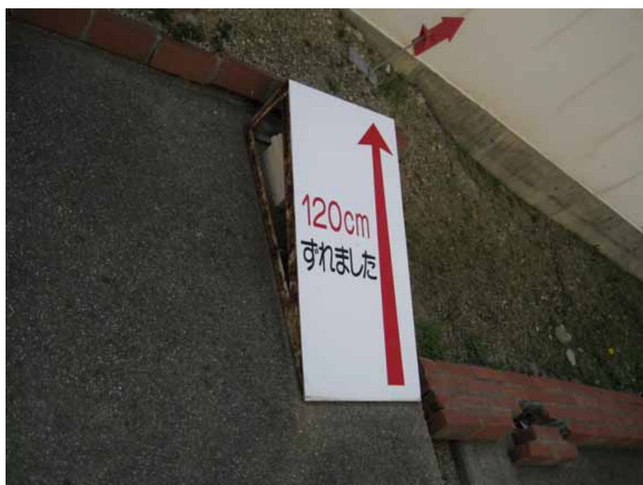
圖 86、北淡震災紀念公園 損壞建築地面 120 公分水平錯移標示
