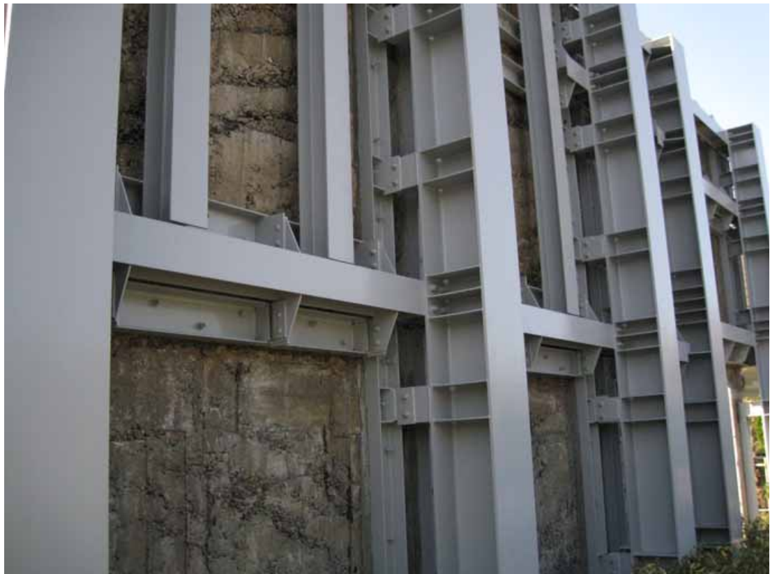
圖 83-1 北淡震災紀念公園 「神戶之壁」(上：正面，下：背面補牆鋼構)
