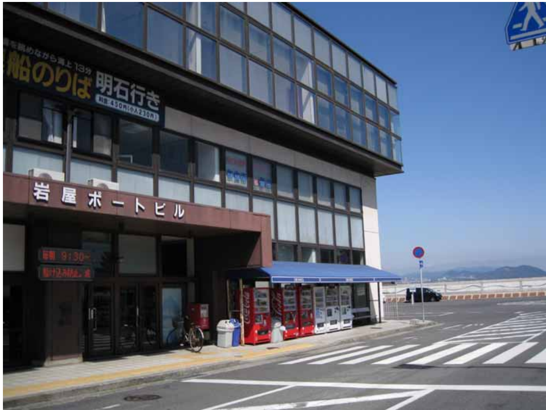
圖 60-3、淡路島「淡路交通」岩屋港站所在建築
