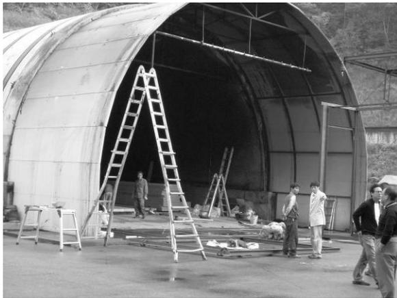
圖 11.隧道火災實驗裝置(建造中)
