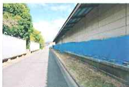
保存修復科學研究室庫房
