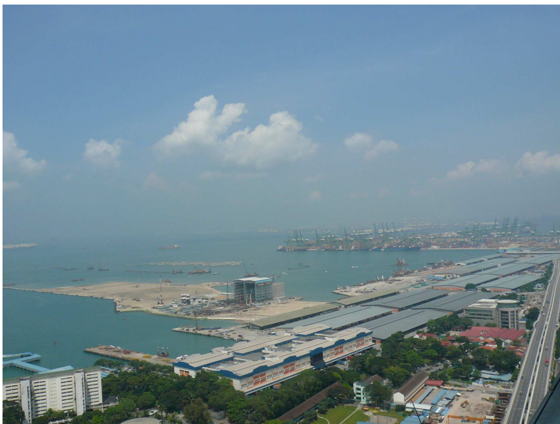
圖 5 鳥瞰新加坡港巴西班讓港區
