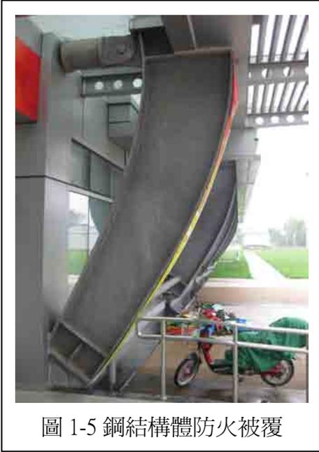
圖 1-5 鋼結構體防火被覆
