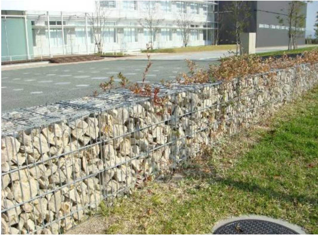
停車場運用蛇籠作為阻隔設施，以石材堆砌增加生物棲息孔隙，並栽植攀藤植物綠化
