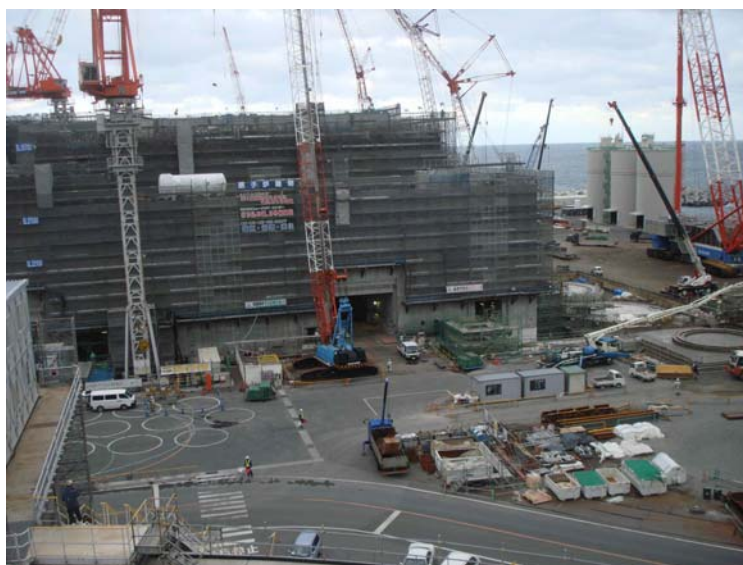
圖 4-5 島根核能電廠 3 號機施工工地
