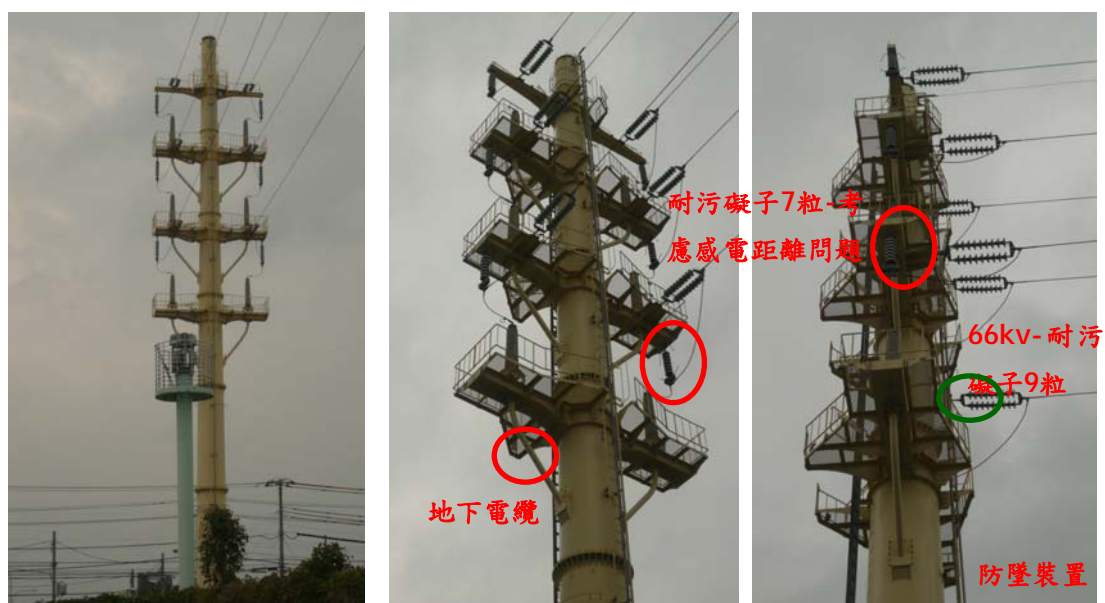
圖 34 京葉線 66kV 送電線#7 景觀鐵塔
