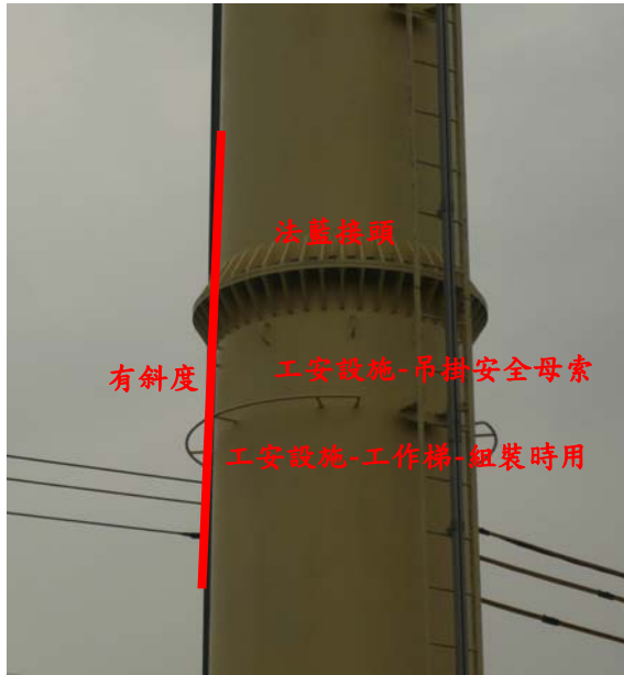
圖 35 京葉線 66kV 送電線#7 景觀鐵塔之附屬設備圖
