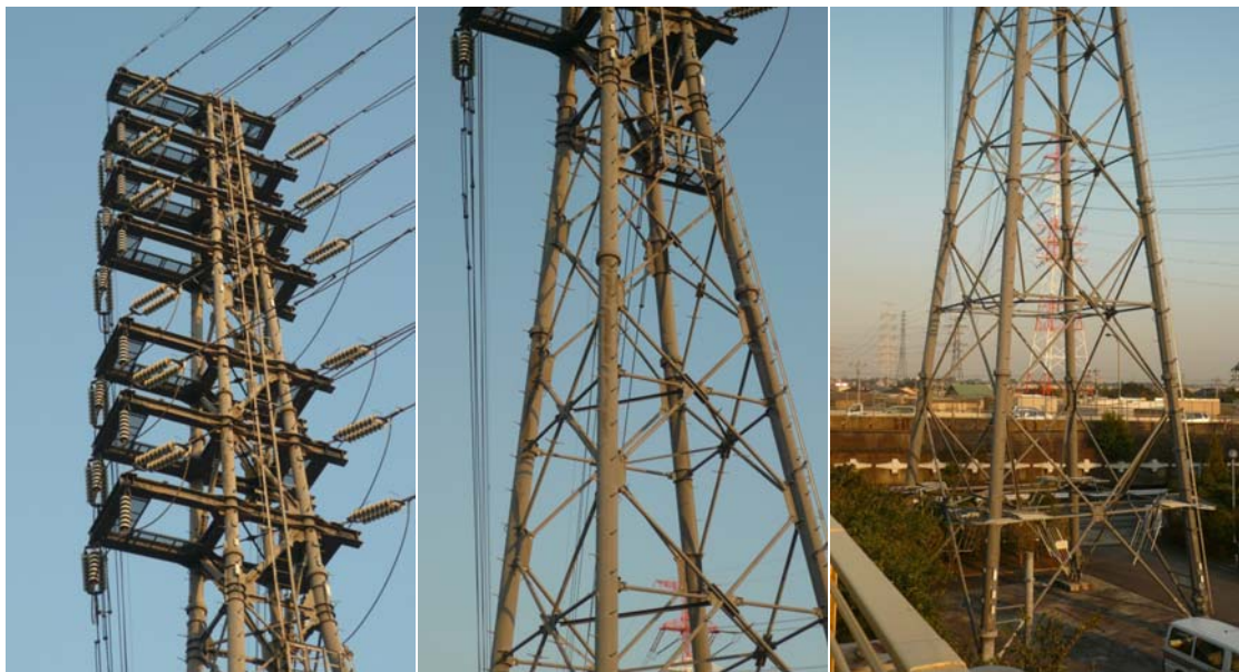
圖 30 千葉~火力線鋼管鐵塔近照圖-1
