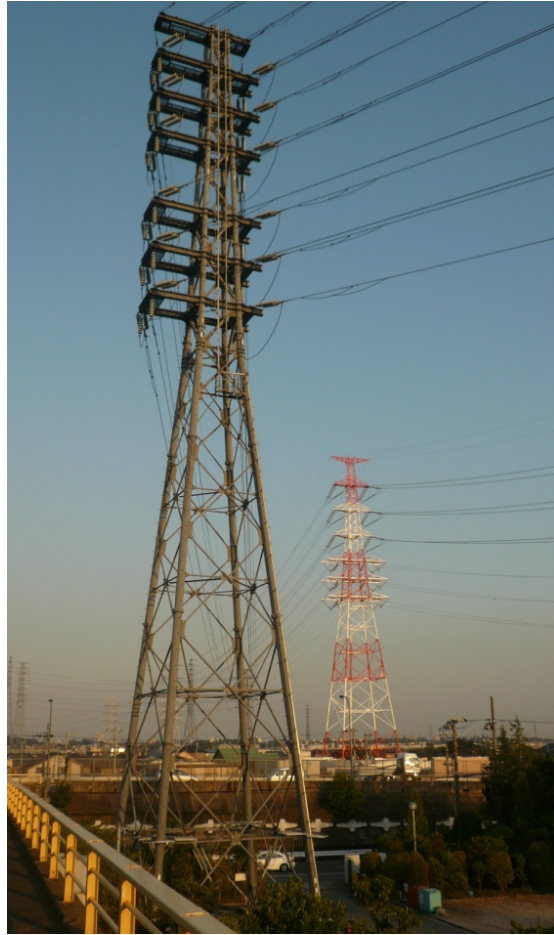
圖 29 千葉~火力線鋼管鐵塔全照圖
