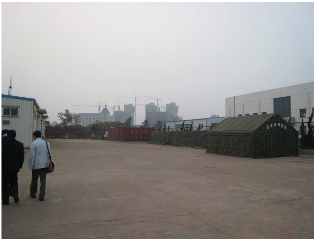
參觀煙台應急中心設備庫 (3)
