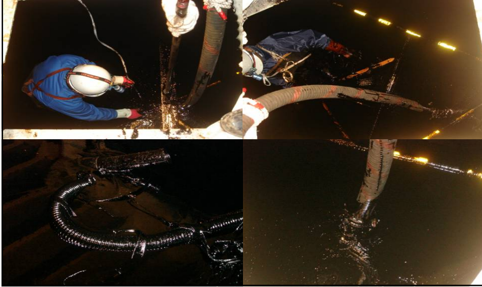
船艙殘油移除—圍堵集中回收殘油
