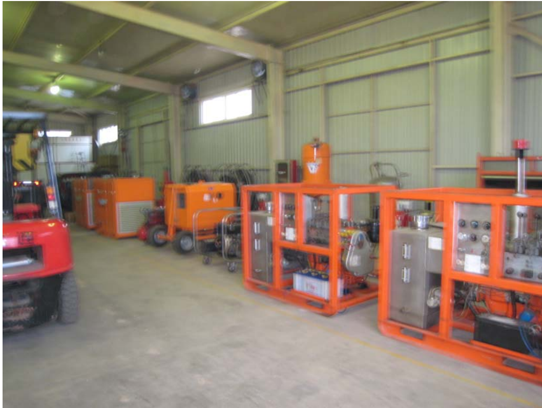
參觀煙台應急中心設備庫（1）
