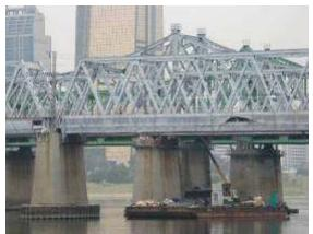
圖 2.23 跨河橋梁利用工作船進行橋體檢修
