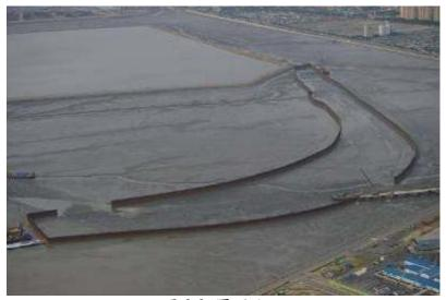
圖 2.8 圍堰施工
