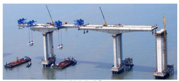
圖 2.12 平衡懸臂工法
