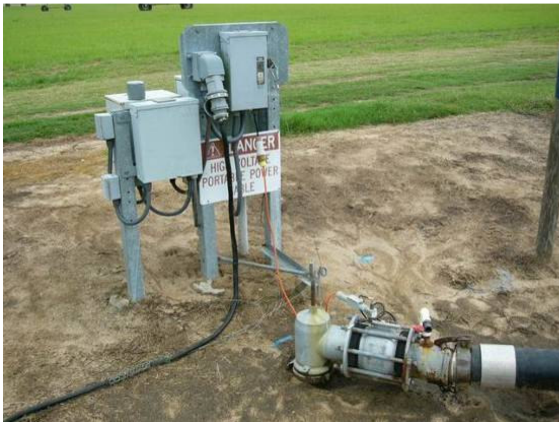
圖3-12 Liner Pivot供水及供電設施
