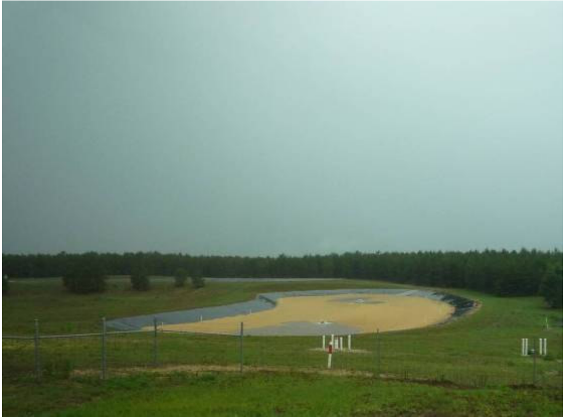
圖4-31 Water Conserv II 快濾滲透盆地
