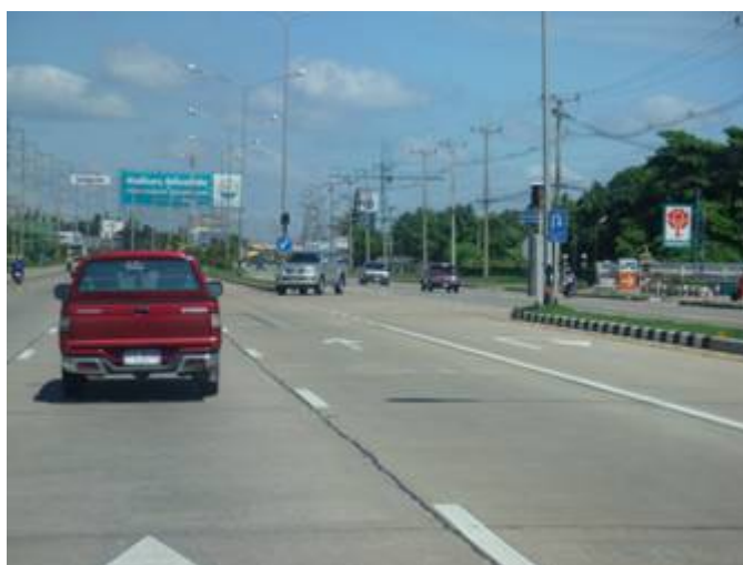
圖 41.迴轉道口標線指引及禁止變換車道標線
