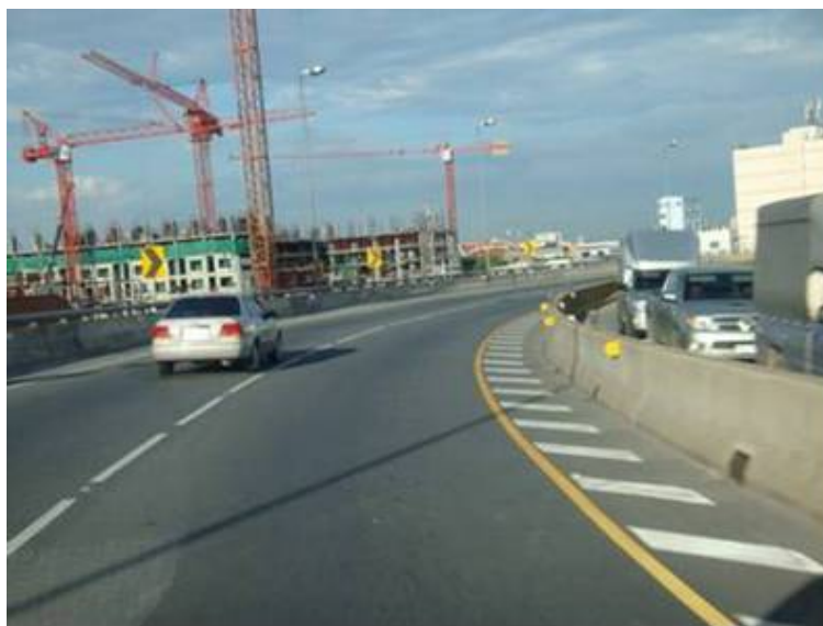
圖 34.彎道之標線、標記設置情形
