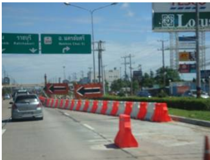
圖 44.施工臨時護欄使用灌水式活動護欄
