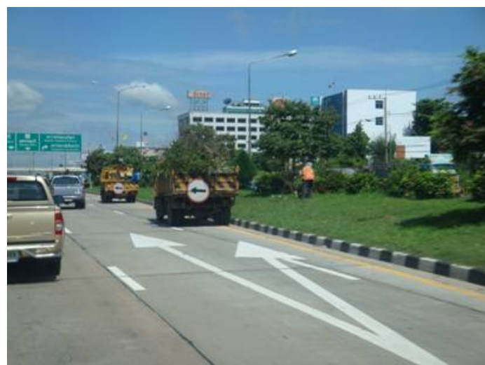
圖 43. 路容養護作業車輛警示設施
