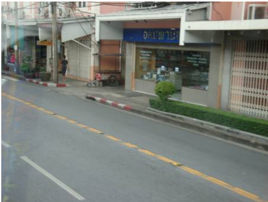
圖 55.大客車專用道相關設施-不同型式標線做區隔
