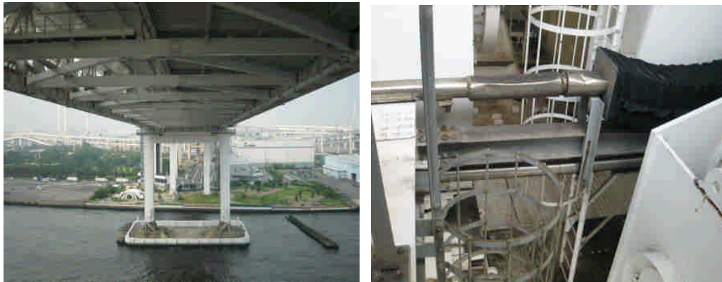
圖 4.3 橋梁監測系統現場處理情形
