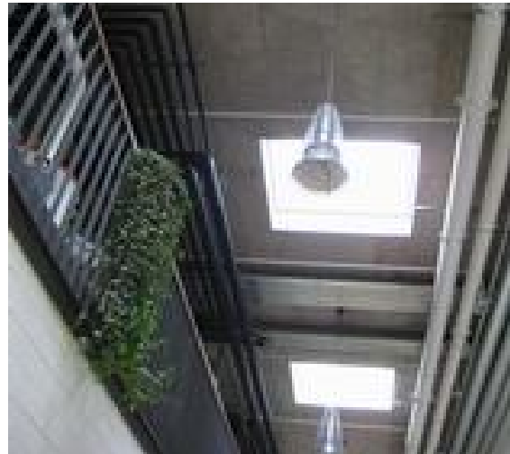
▶ 室內照明及設備管路明管化
