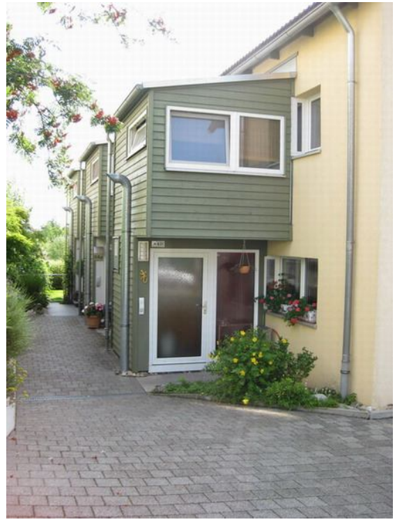
▶ 自然通氣之進出管路及明管排水
