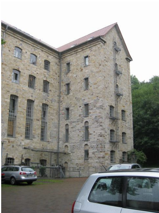
▶ 舊建物整修辦公室外觀
