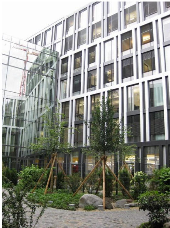
▶ 戶外中庭及建物伸縮遮陽
