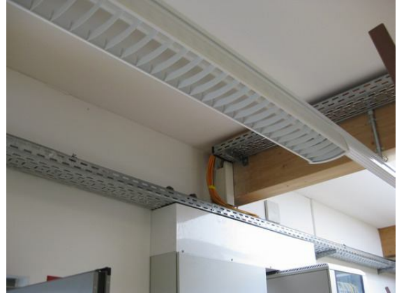
▶ 室內照明及設備管路明管化
