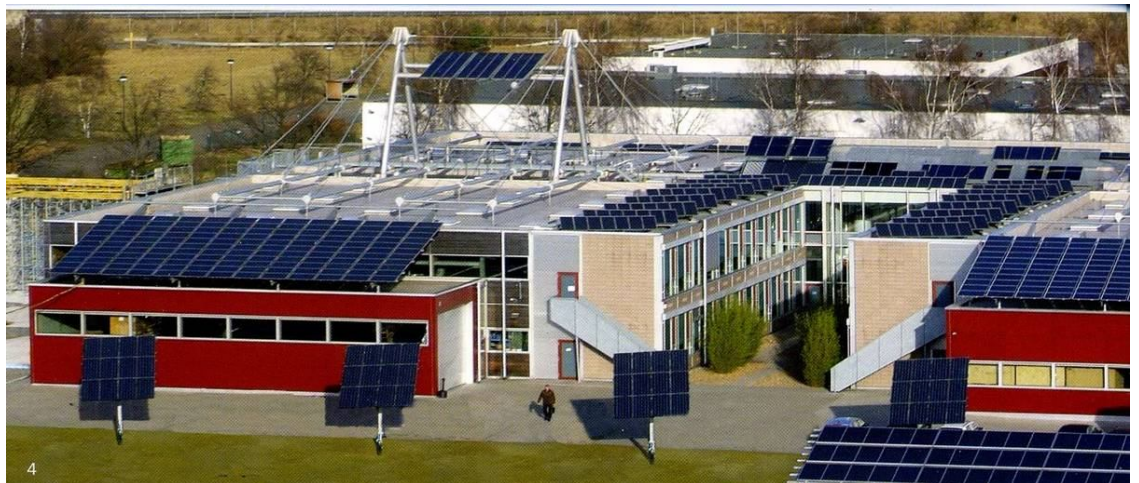
▶ 屋頂太陽能光電板結合整體外觀-摘自廠商書面資料
