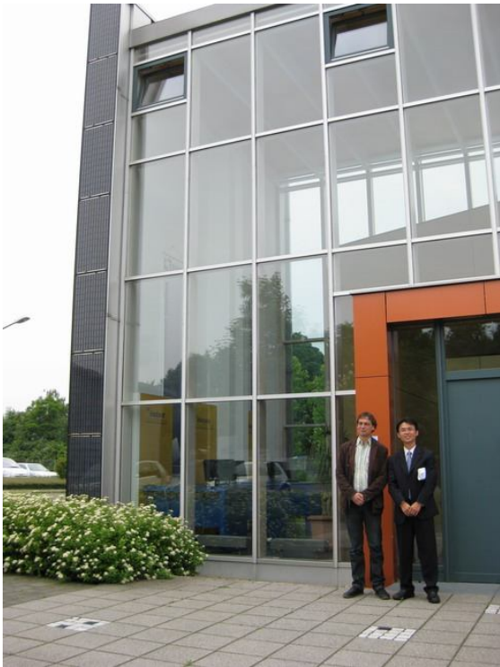
▶ 入口大廳外牆結合太陽能光電板
