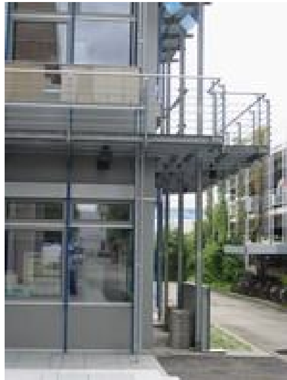
▶ 採輕型鋼構造之 IBP 實驗室
