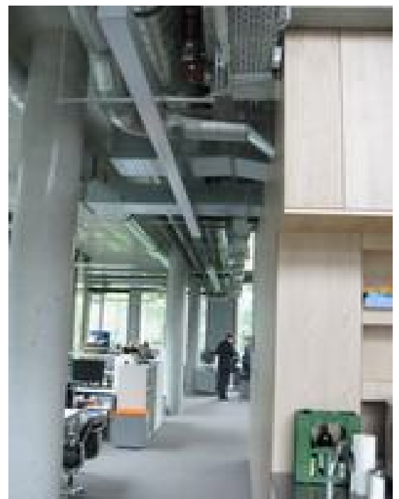
▶ 設備管路明管化
