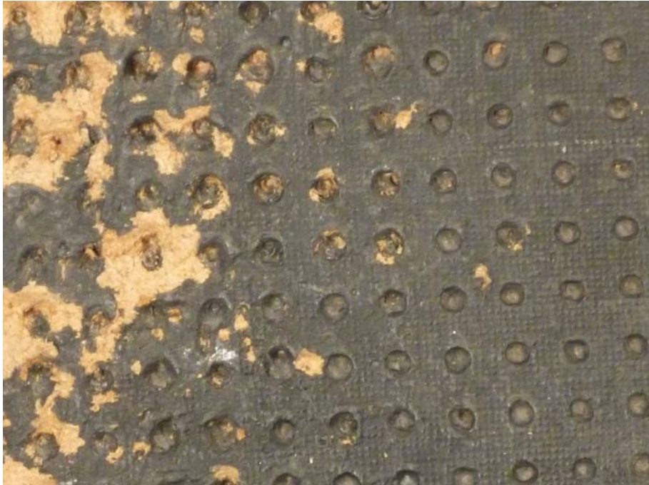
支撐板之緩衝墊及煞車孔
