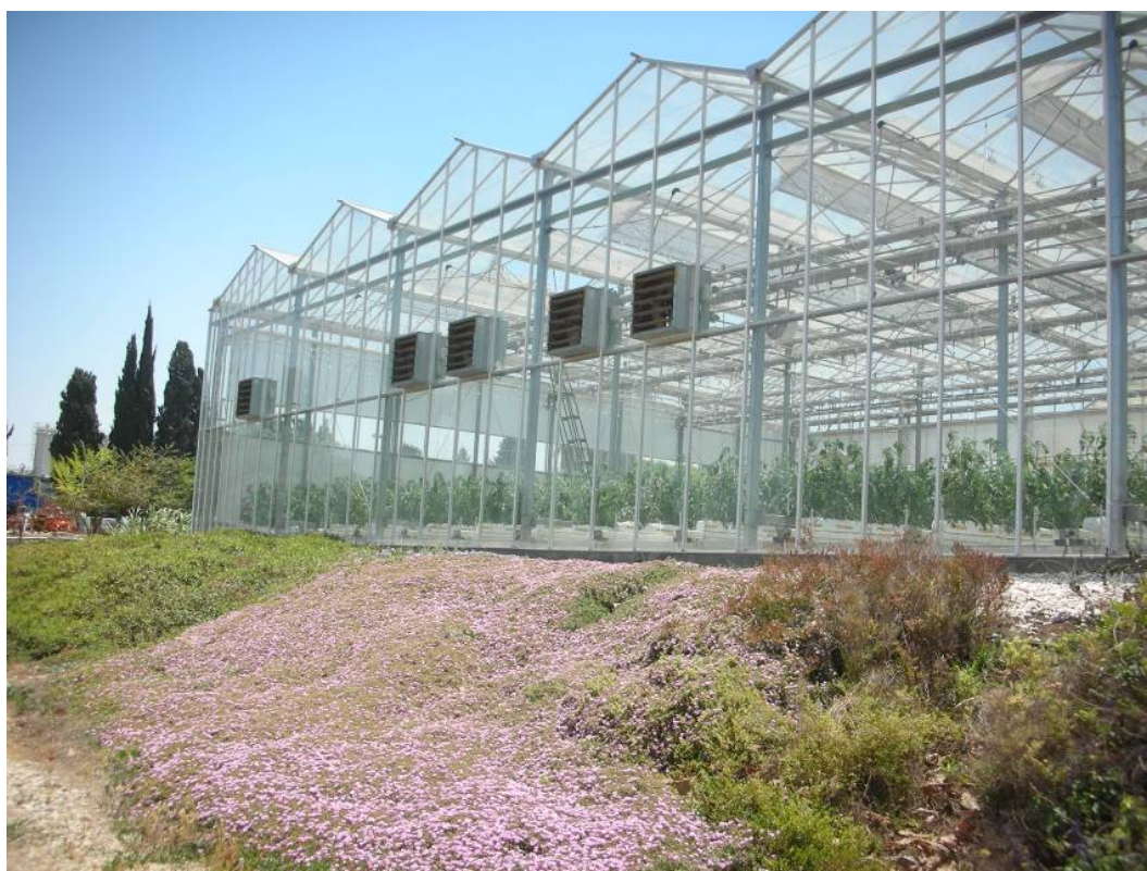
圖 48. Netafim 設計的 pad and fan 玻璃溫室
