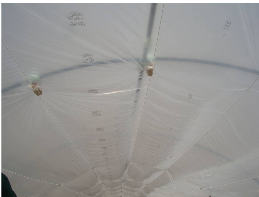
圖 58. 冬季使用雙層膜保溫溫室
