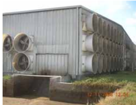
圖 7. North Florida Holstein 牧場所使用的隧道式通風系統。此系統須精密計算才能發揮最佳效能。
