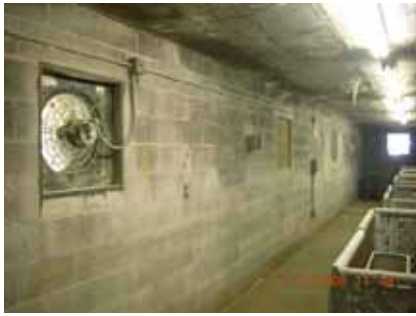
圖 14. 利用風扇達到畜舍換氣效果；或者以塑膠風管下的小洞，提供涼風。
