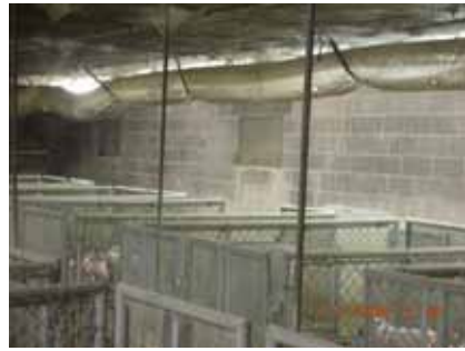
圖 14. 利用風扇達到畜舍換氣效果；或者以塑膠風管下的小洞，提供涼風。
