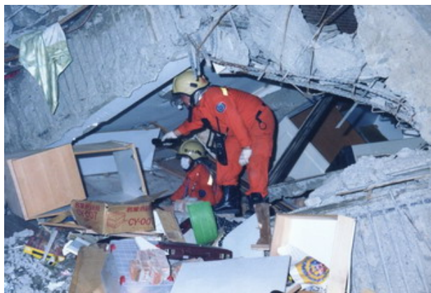
九二一地震台北市東星大樓倒塌
