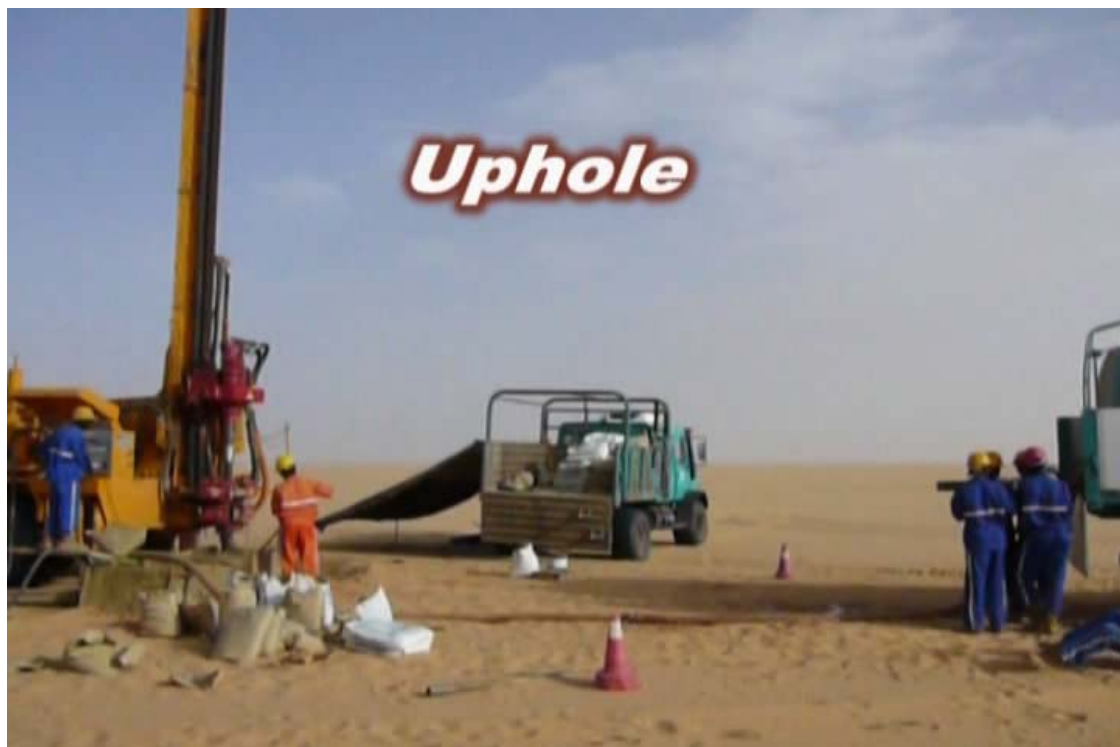
照片 7 風化層鑽孔施測作業
