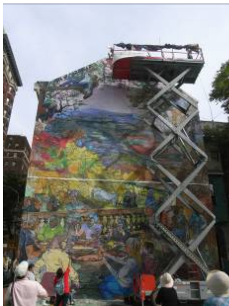
巧遇藝術家施工現場
