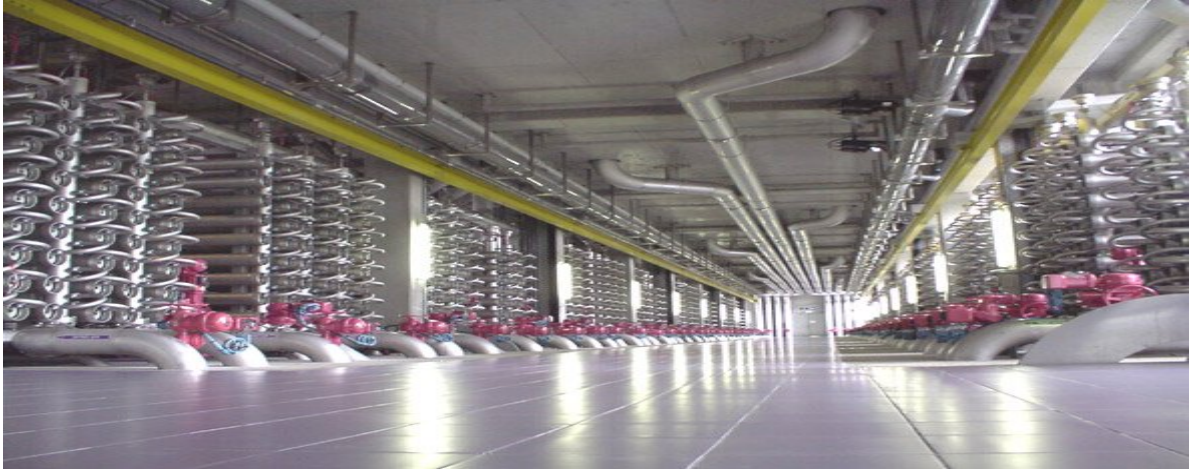
圖 16 ( 5 ) Mery-sur-Oise 場奈米薄膜設備裝設概況
