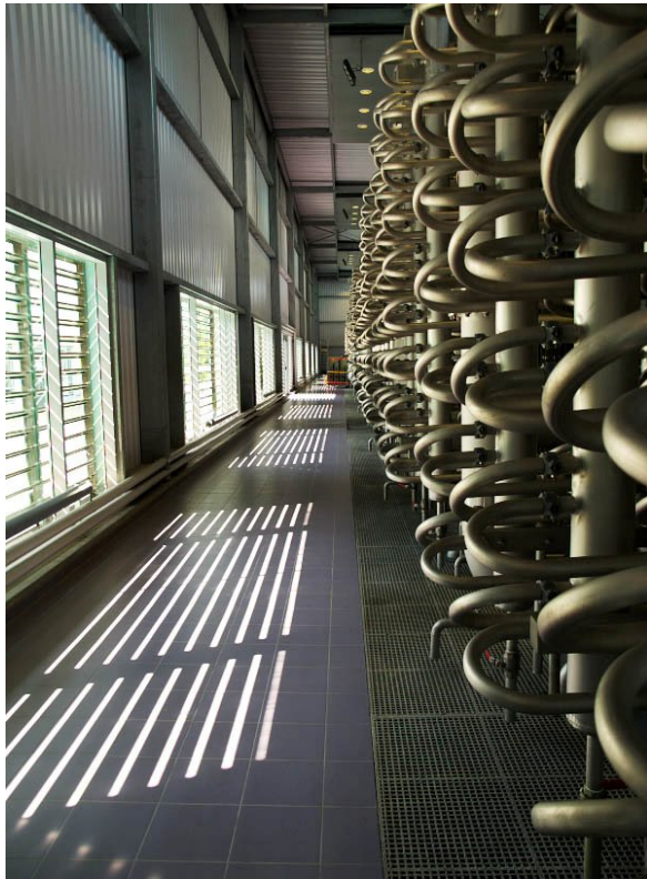
圖 16 ( 5 ) Mery-sur-Oise 場奈米薄膜設備裝設概況
