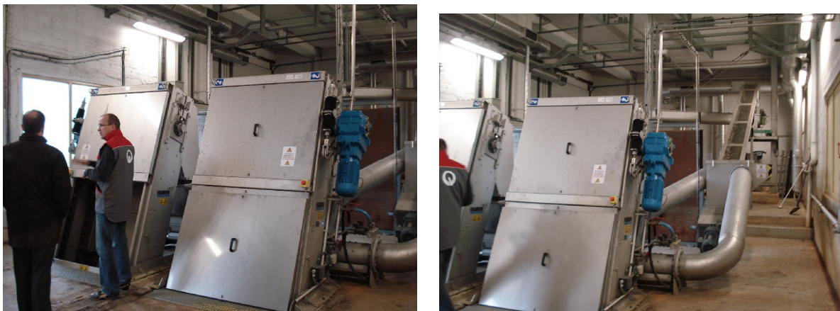
圖 26 La Chauvinière 廠所使用連續篩除前處理設備
