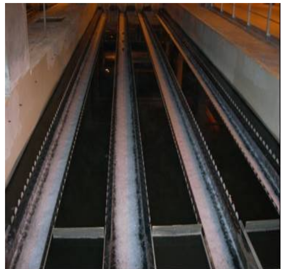
Amphitria 廠初沉採用 Multifloc 設備
