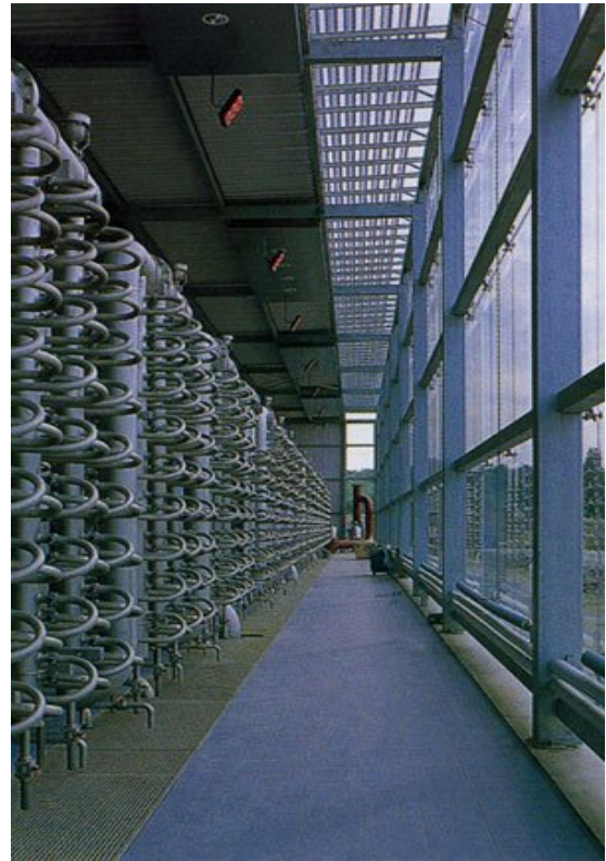
圖 16 ( 5 ) Mery-sur-Oise 場奈米薄膜設備裝設概況
