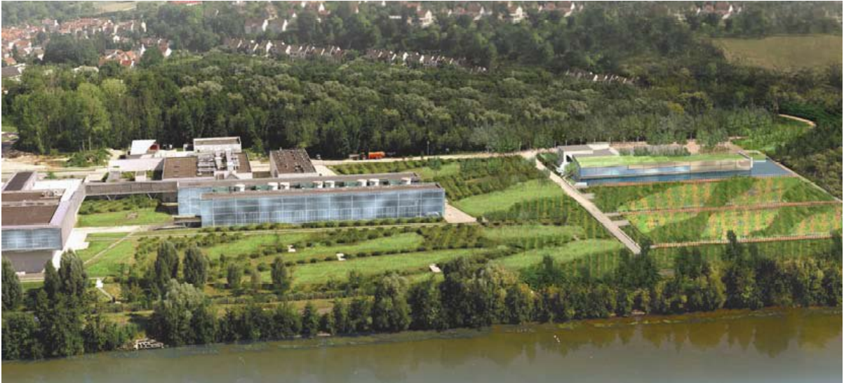
圖 15 ( 3 ) Mery-sur-Oise 淨水場全景
