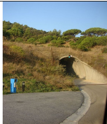
Amfithria 污水處理廠對外交通之山洞入口
