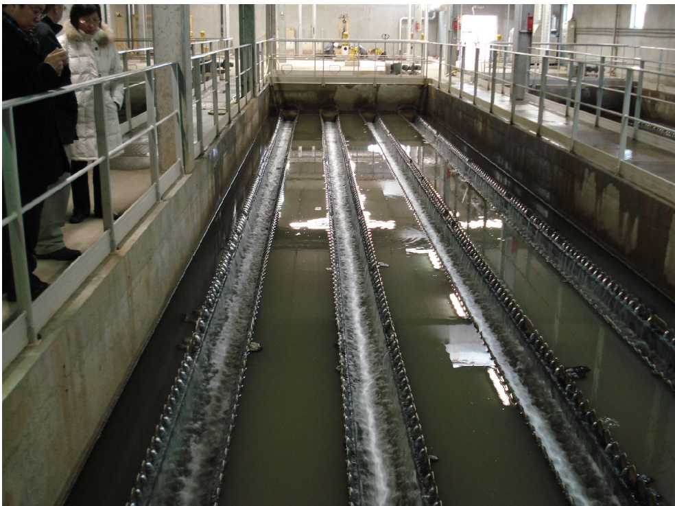
圖 27 La Chauvinière 水處理廠使用 ACTIFLO 沉澱技術
