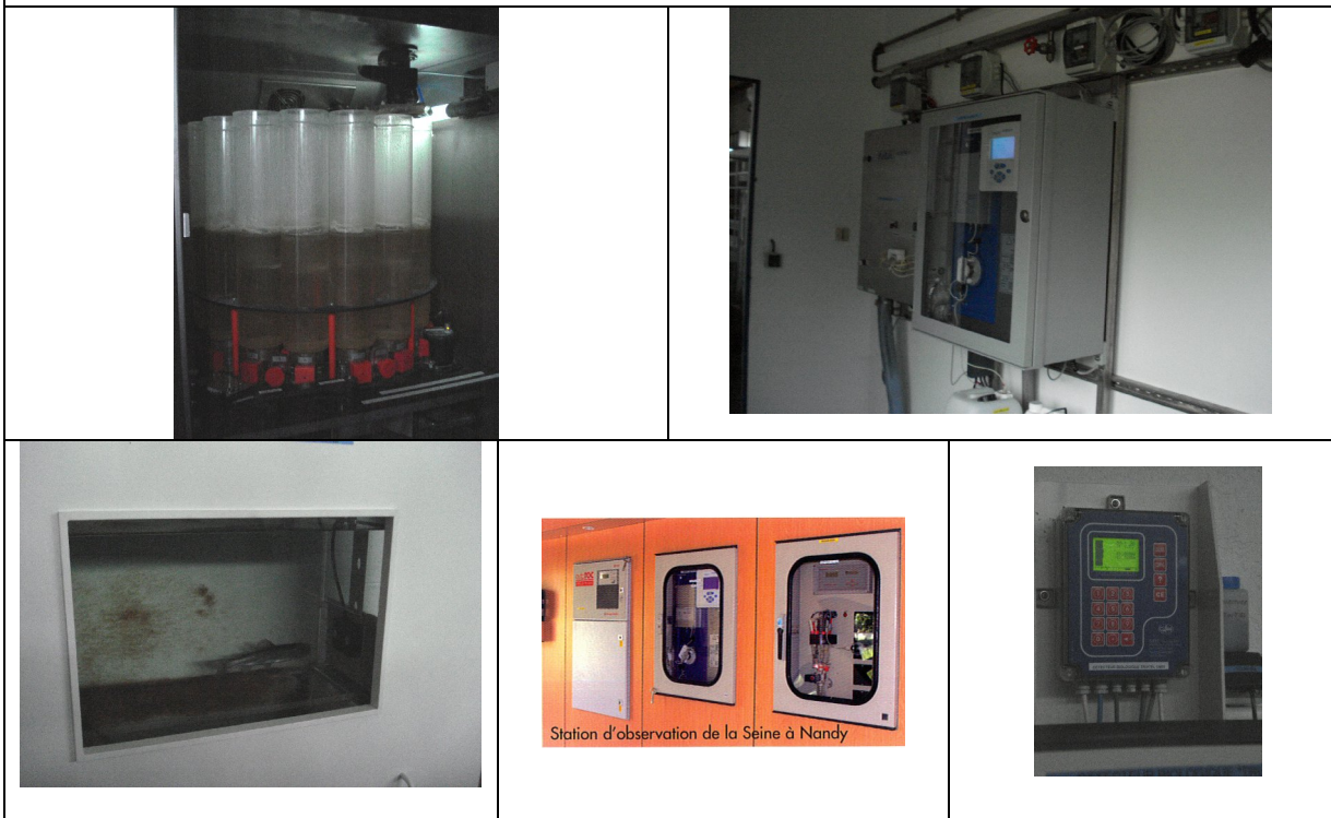
圖 29 Morsang-sur-Seine 高級淨水處理場 - 原水監視設備
