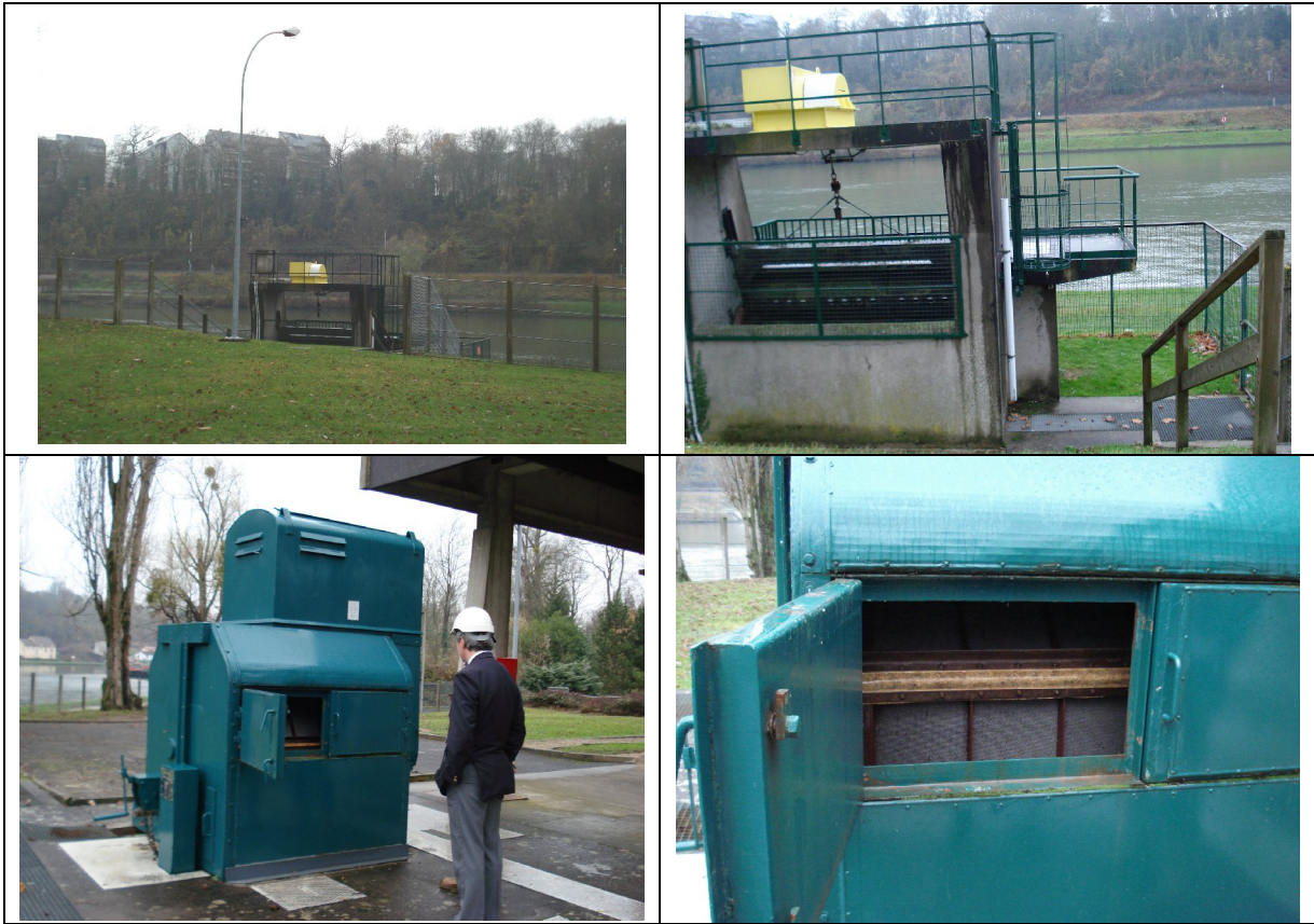
圖 29 Morsang-sur-Seine 高級淨水處理場 - 前處理粗篩及細篩設備
