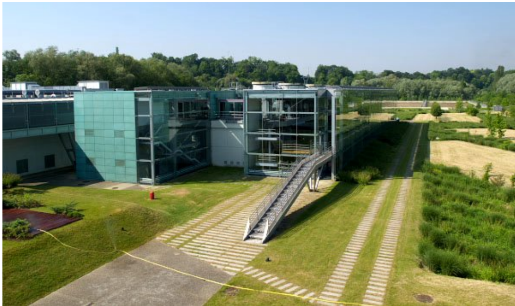
圖 16 ( 9 ) Mery-sur-Oise 場奈米薄膜設備全景
