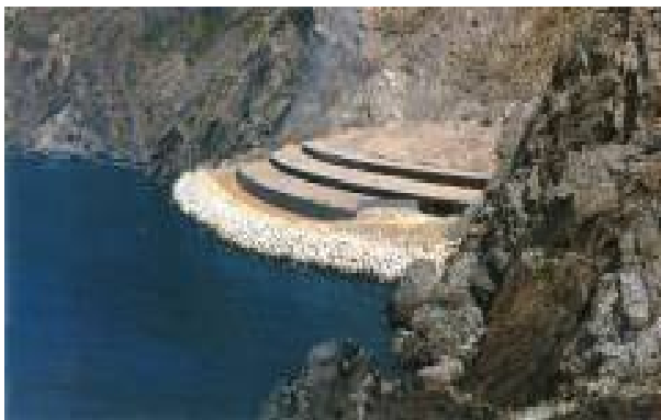
Amfithria 污水處理廠外部全貌
