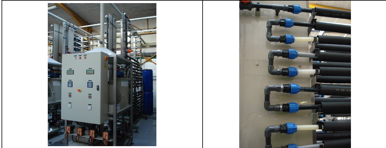
(5) CIRSEE 模型廠基地正進行化學類管材可靠性測試評估研究
