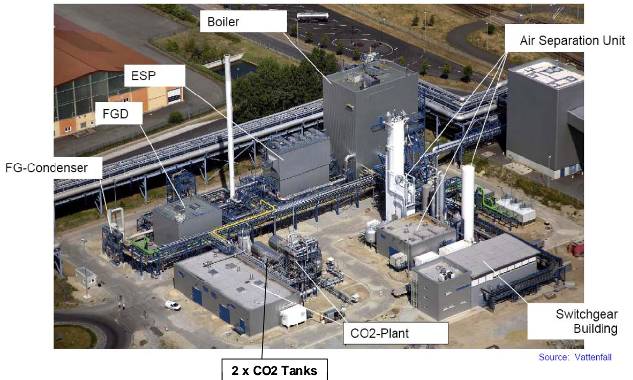
圖 12、Schwarze Pumpe Oxyfuel CCS 示範廠設備
