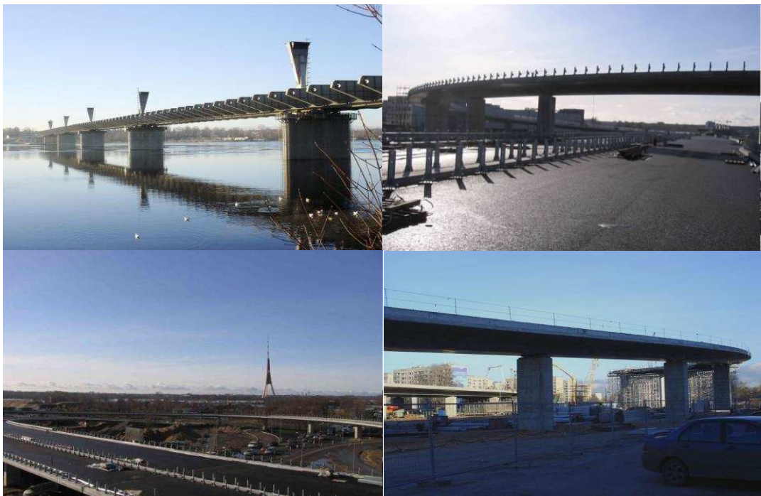
▲興建中之新跨河大橋（New Southern Bridge）
