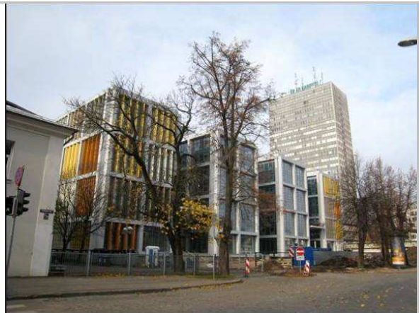
▲建築立面外觀稍作變化，為街景增色許多。
