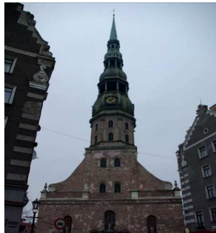
▲聖彼得大教堂（Lutheran Saint Peter's Church）原為歐洲最高的木構造建 築，1970 年其尖塔改為鋼結構，有電 梯可直通樓頂一覽里加風光。頂端有 生鐵鑄的公雞風標，被認為是吉祥的 標誌，能驅鬼避邪，雞叫三遍，天亮 之時，魔鬼就得返回地獄。
