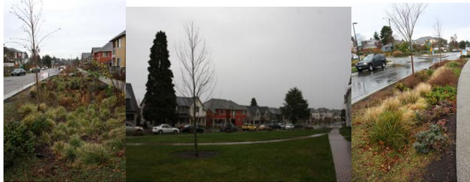
工程設計主要理念在增加雨水蓄留及入滲，方式包括減少不透水鋪面、增加表面孔隙率（如道路材質更改）及設計適當植栽土壤以維持適當入滲速率達到過濾去除污染物質的效果。
