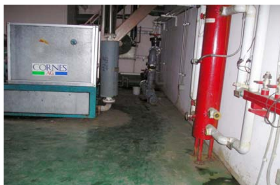
圖 18.町村牧場廢水處理與沼氣發電設備
