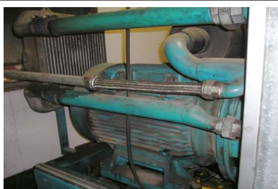
圖 20.町村牧場沼氣發電機
