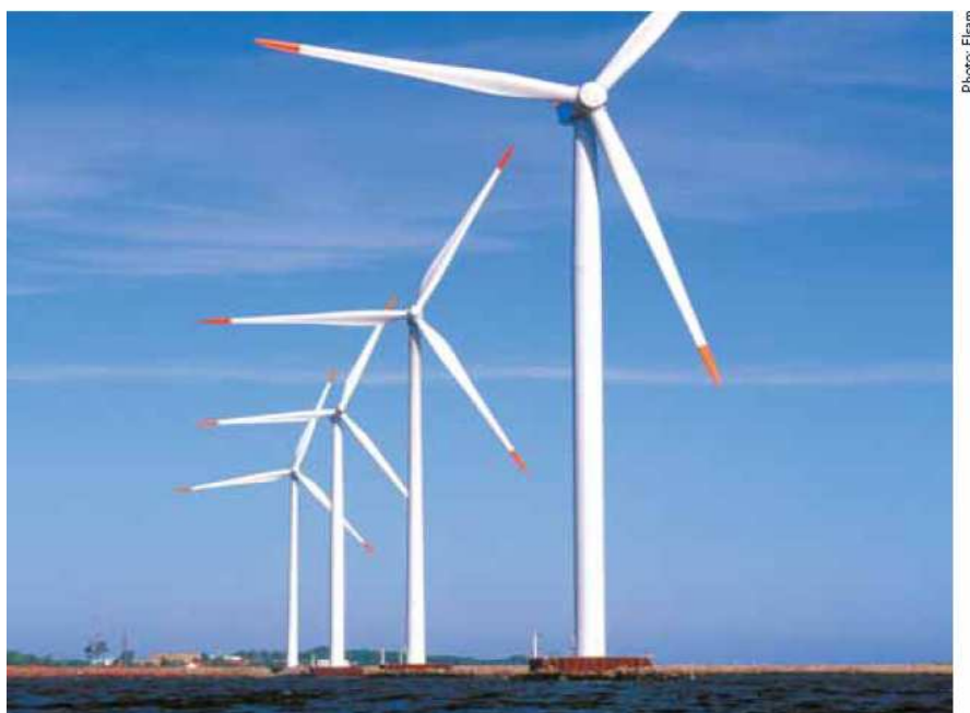
圖 8 Frederikshavn 離岸風力發電廠
