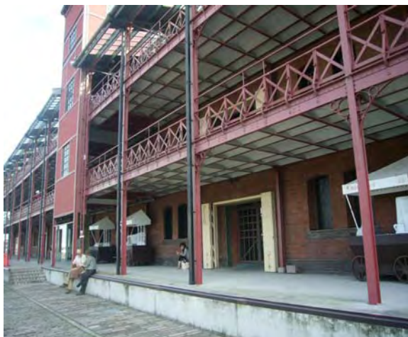
紅磚倉庫外側鋼架
