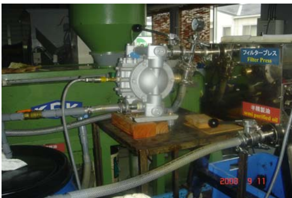
生質能源提煉設施
