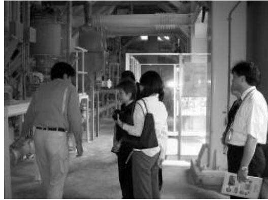
⇧ 中和工場內部混合設備
