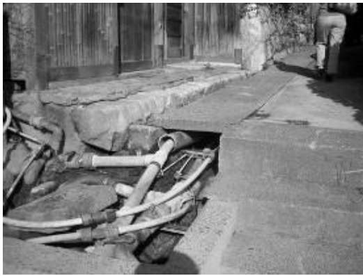
⇨ 有馬温泉之「金泉」富含鐵質，輸水管線皆附著鐵銹，需定期抽換⇨
