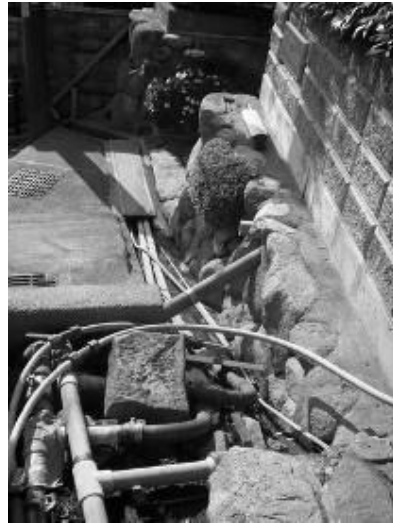
⇨ 有馬温泉之「金泉」富含鐵質，輸水管線皆附著鐵銹，需定期抽換⇨
