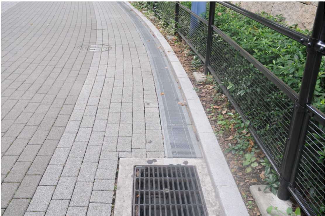
圖 7 完整且平順之路邊排水設施（大阪市）
