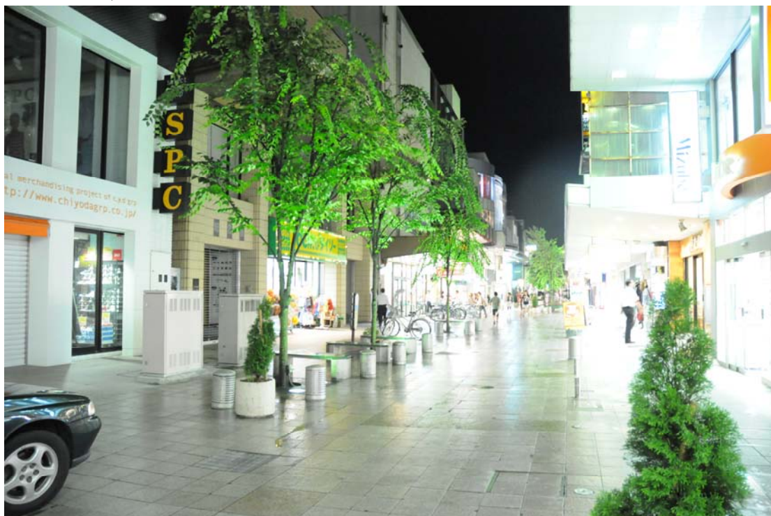
圖 1 電力配電箱設置不影響道路景觀（金鐸市街道）
