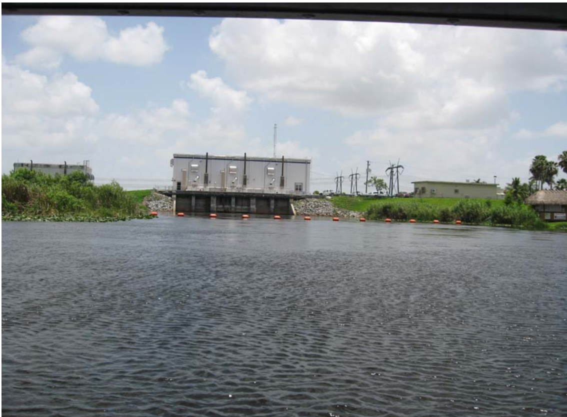
圖 8.大沼澤與人工運河(大排水道)之間的水壩，用以維持大沼澤水位
