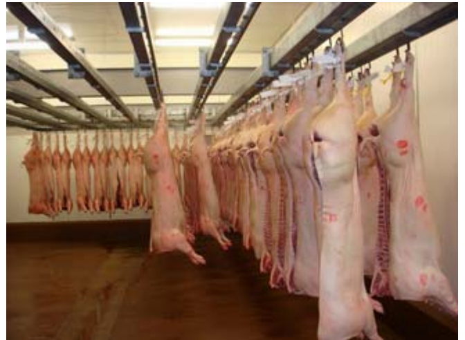
圖 42. 『Perth Pork Company』豬隻屠宰場屠體預冷室
