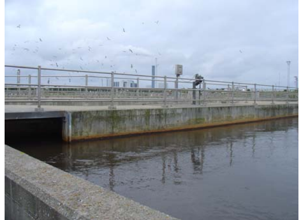
考察科倫德堡（Kalunborg）生態工業區 污水處理廠設施
