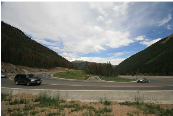
圖 23 U.S.40 彎道線形改善情形
