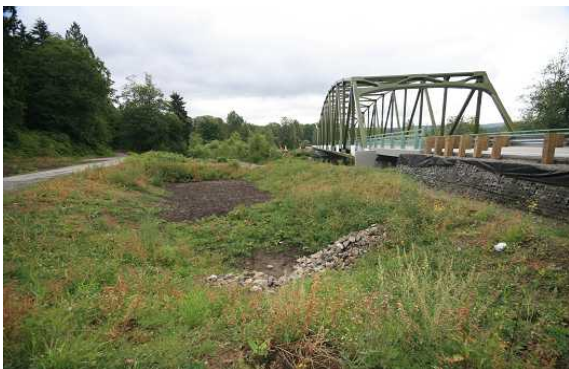
圖 21 Tolt Bridge 與滯洪池
