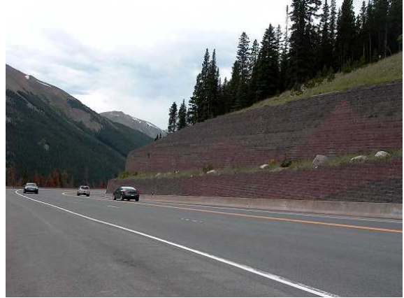
圖 26 擋土牆配合地景設置
