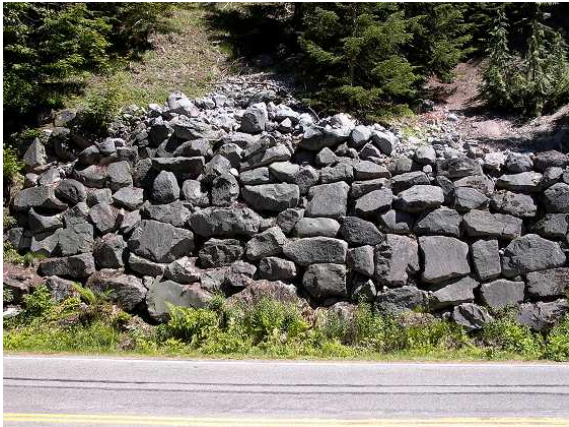
圖 19 擋土牆以石塊堆砌
