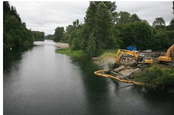
圖 22 Tolt Bridge 舊橋基礎拆除避免雜物污染水質施工情形
