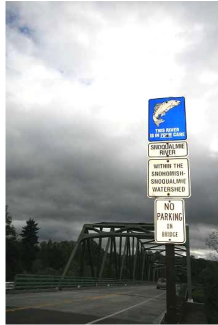
圖 20 新完成的 Tolt Bridge
