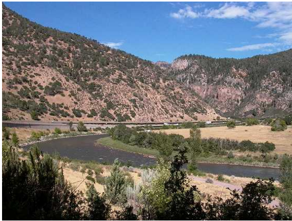
圖 27 I-70 公路雙階棧橋
