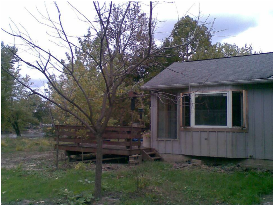
圖 3.3 愛荷華河邊受 2008 年 6 月水災影響的住宅(窗戶仍依稀可見淹水痕跡)
