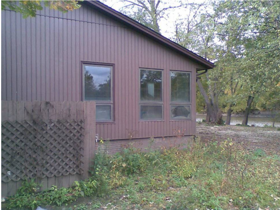
圖 3.2 愛荷華河邊受 2008 年 6 月水災影響的住宅(窗戶仍依稀可見淹水痕跡)
