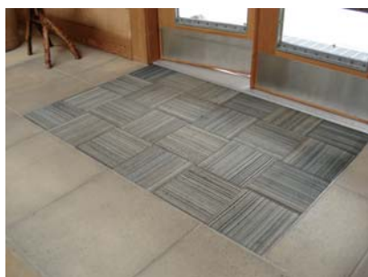
採用以回收輪胎製成的地墊設 置入口空間
