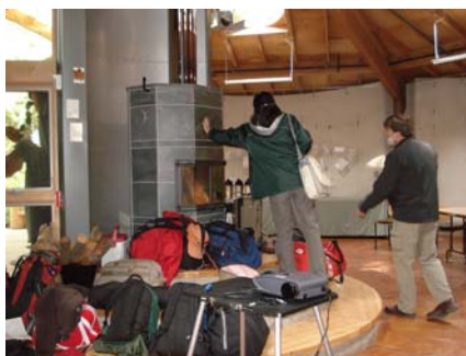
教室內有可為替代熱能來源的高效能暖爐設計
