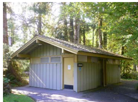
Hoh rain forest 露營地設置廁所，並可提供簡單盥洗
