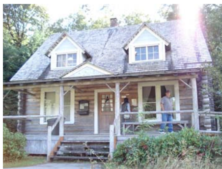
奧林匹克國家公園 Storm King Ranger Station 兼遊客資訊中心 (只在夏天開放)
