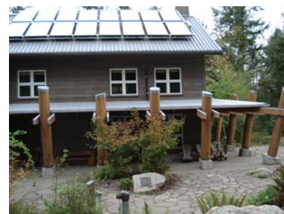
學員宿舍的屋頂將太陽能轉化為熱水加熱系統，降低使用電力設備造成的空氣污染
