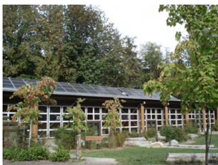
教學教室屋頂設置的大型太陽能 光電板，屋頂的設計可獲取更多的 能源及便於雨水收集
