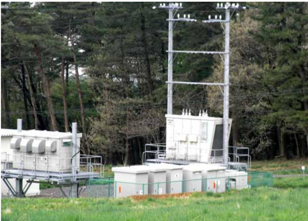
圖 17 環路平衡控制器 (Loop Balance Controller)與外觀 -左 500kVA、右 1000kVA
