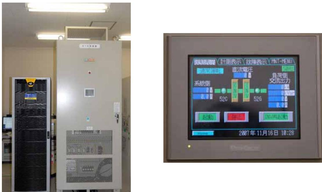
圖 7 背對背電壓源型換流器控制盤與顯示畫面（Simulator and BTB control board）
