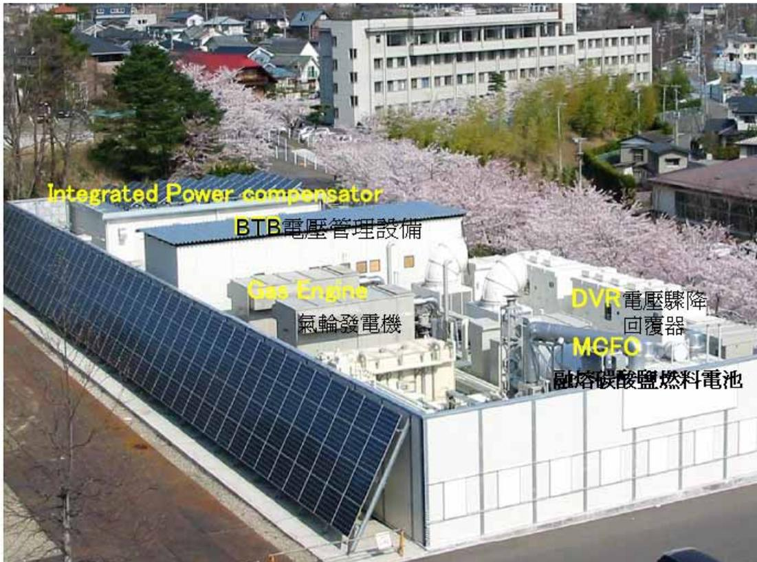
圖 4 仙台微型電網能源控制中心架構
