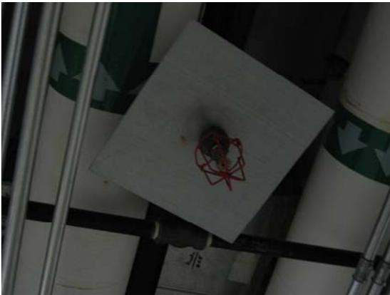
圖 39,40 撒水頭外部裝有金屬防護罩以防碰撞漏露
