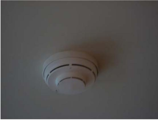
圖 47 偵煙型探測器
