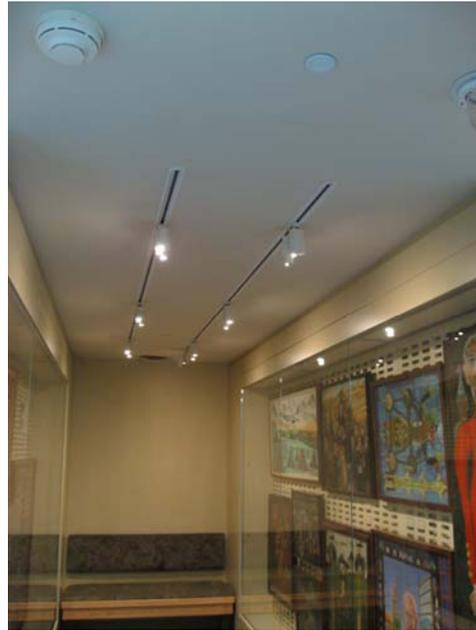
圖 19 館內油畫展示空間，裝設隱藏式自動撒水設備及偵煙型探測器
