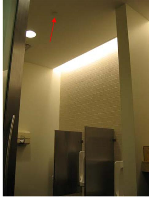
圖 58 洗手間裝設自動撒水設備
