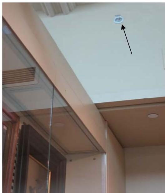
圖 20,21 館內油畫展示空間靠近屋頂處，除裝設隱藏式自動撒水設備及偵煙型探測器外，另裝側牆式撒水頭
