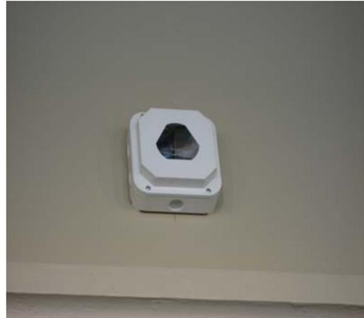
圖 25 館內挑高走廊，選用光電分離型探測器(Beam detector)
