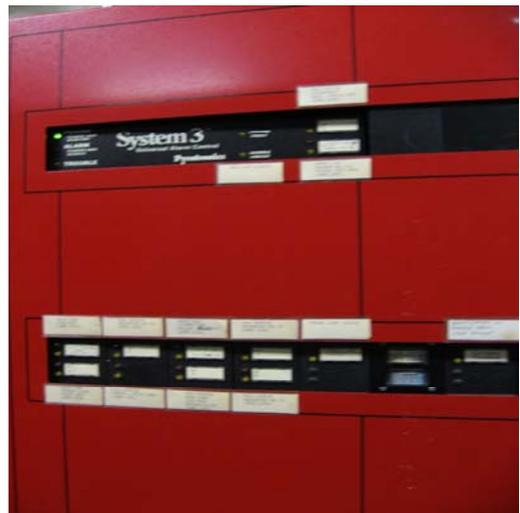
圖 109 火警系統控制盤外觀
