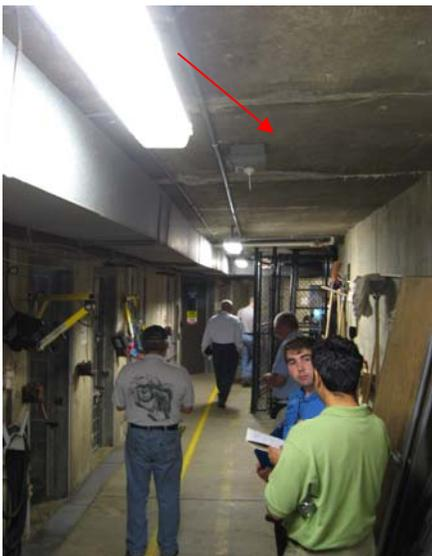
圖 114 檢查 Spectacled Bear House 走廊，上方裝設 Heat Detector
