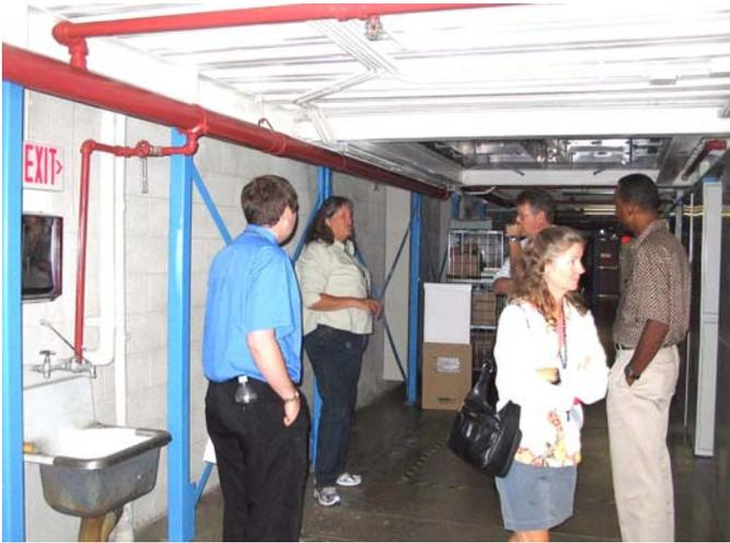
圖 72 紅色管線為撒水設備，故外部均裝有 mechanical guard 金屬線圈防護，工作室走廊會臨時堆放一些典藏物箱，並有洗手檯設計。
