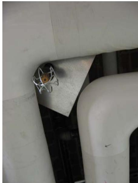
有關探測器安裝位置，國內法規限制探測器的安裝不能與裝置面傾斜逾 45 度，圖 43 所示安裝例則與牆壁成 90 度安裝，顯與我法規不符，卻是世界各國常見安裝例。我引自日本的規定只針對常態天花板安裝例加以規範，忽略歐美國家可為特殊空間及安裝位置開發適用探測器之事實；然在美國各處均可見探測器安裝與裝置面成水平 90 度之實例，為達整體設計需求及美觀，美國國家藝術博物館是最佳示例。
