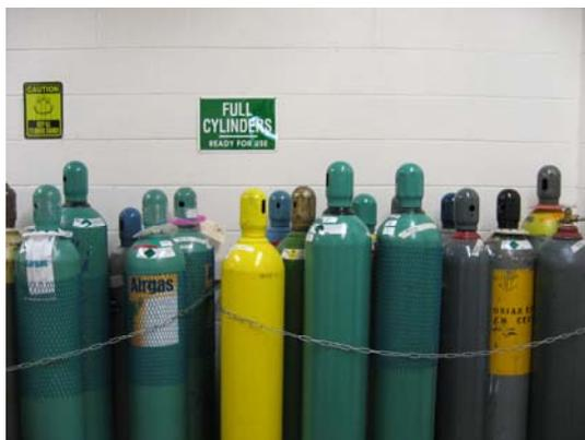
圖 98 氣體鋼瓶用鍊索固定
