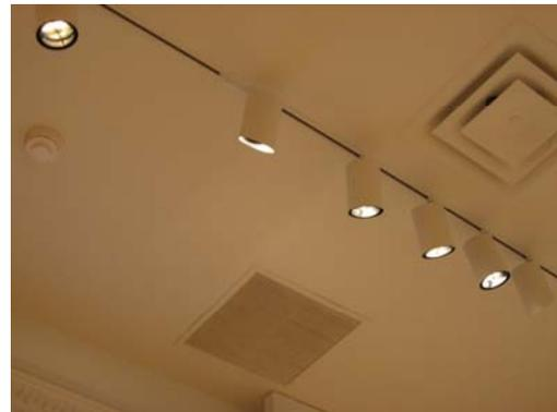
圖 30,31 展示空間設置排煙設備，明顯辨識空調與排煙口之區別，且排煙開口附近有設置連動之偵煙型探測器。
