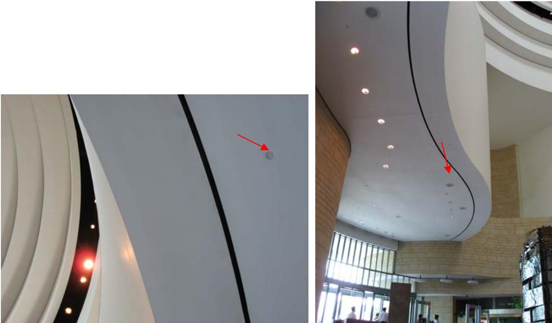
圖 51,52 入門挑高大廳設計，全棟建築採用隱藏式自動撒水設備。
