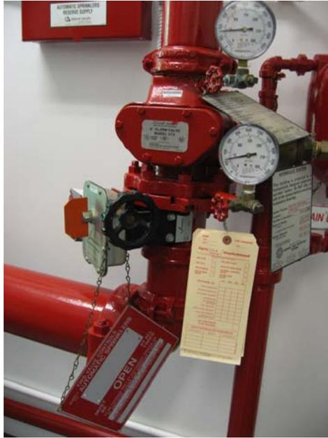
圖 95 消防幫浦定期維護檢查卡及 Switch Open 標示牌
