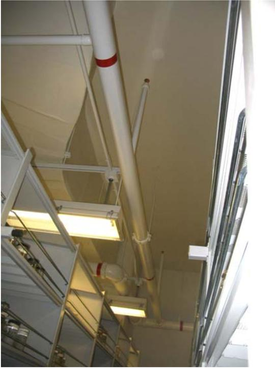
圖 82 新設典藏室 5(Pod 5)之可移動式鐵櫃 (Moveable Shelving)上方設置白色撒水管上裝向上型 (high above the Collections)
