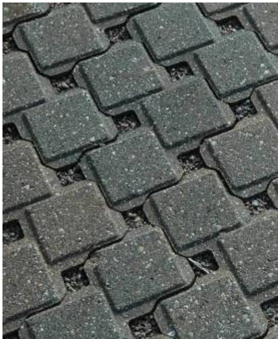
圖 76 The Morton Arboretum 停車場透水磚設計
