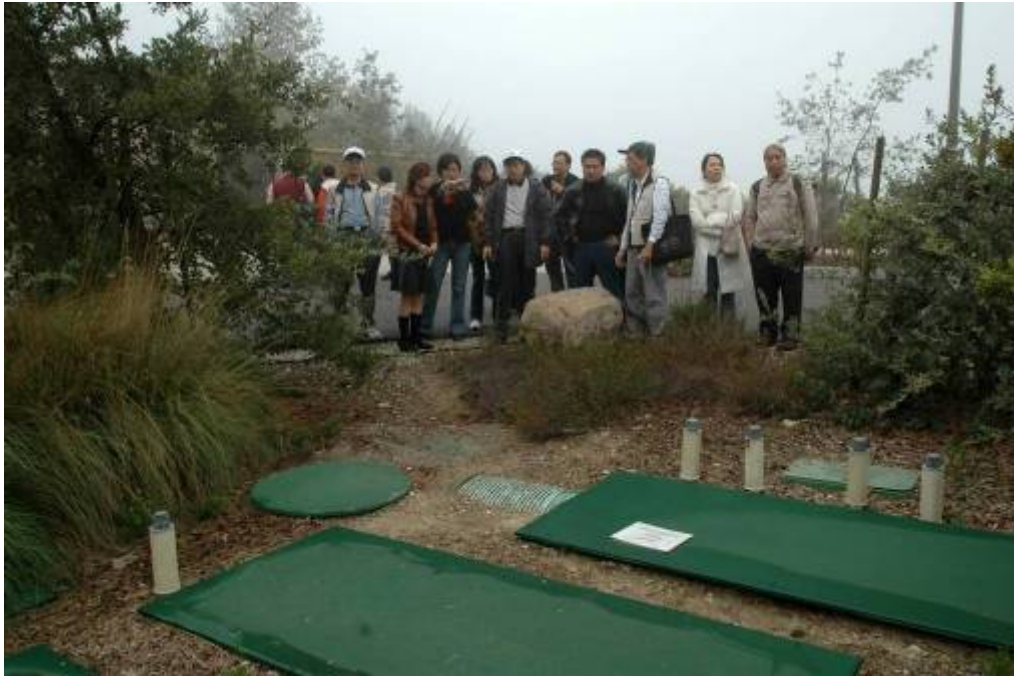
圖 81 Audubon Center 入口透水鋪面與雨水收集利用設施
