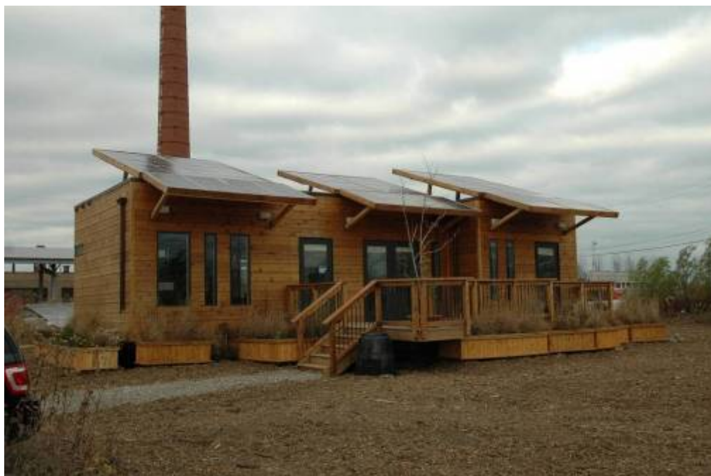
圖 38 芝加哥綠色科技中心與伊利諾大學共同建立的太陽光電發電與木構造實驗屋
