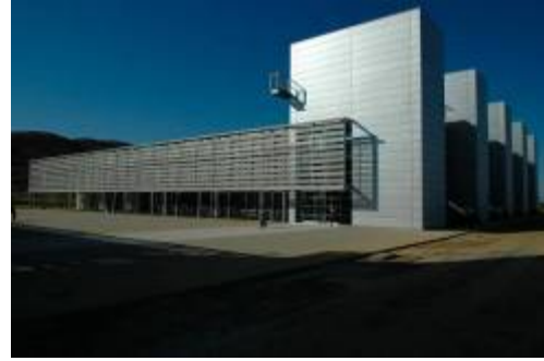
圖 48 LA Diamond Valley Lake Visitor Center 建築外觀
