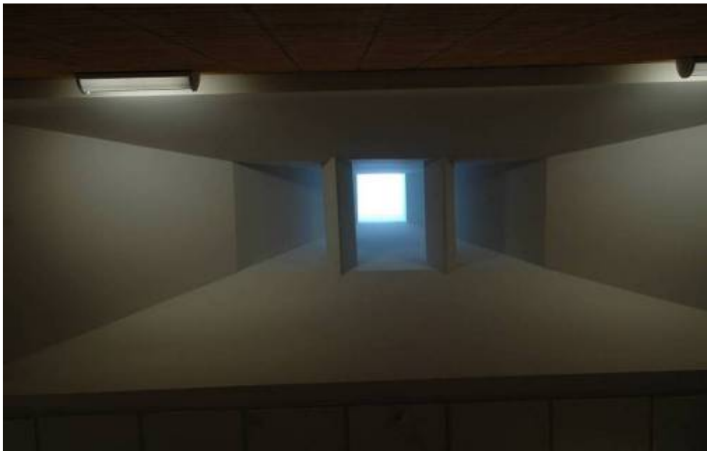
圖 35 芝加哥綠色科技中心採光天井與浮力通風口
