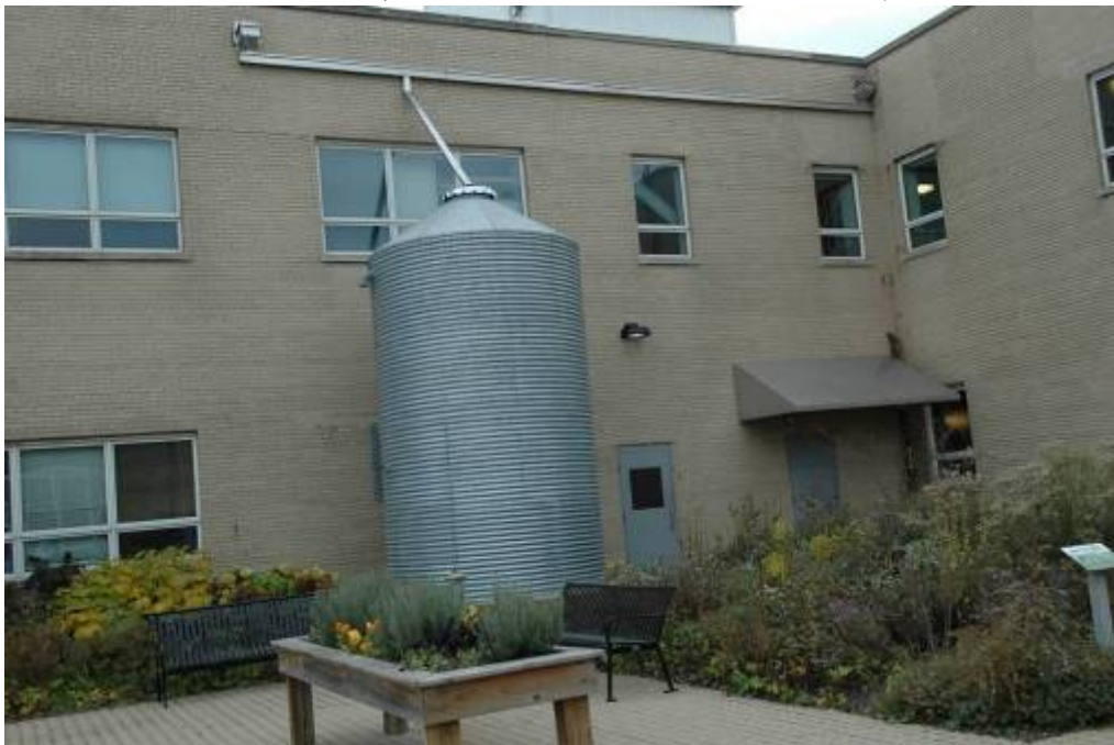
圖 37 芝加哥綠色科技中心雨水收集貯留槽
