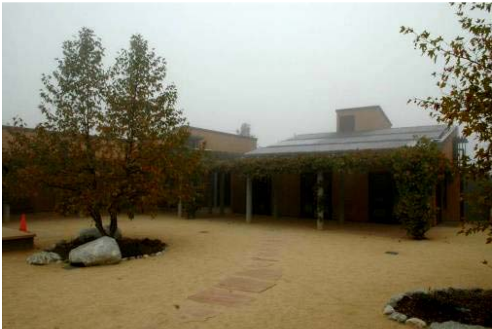
圖 82 Audubon Center 外牆立體綠化與屋頂太陽光電、太陽熱能設施
