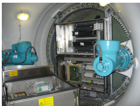
圖 3. HUB 內部系統控制箱
