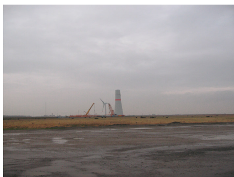
圖 17. ENERCON 興建中的 E126 風力機
