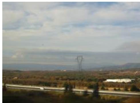
070 輸電鐵塔(1 回線)2
