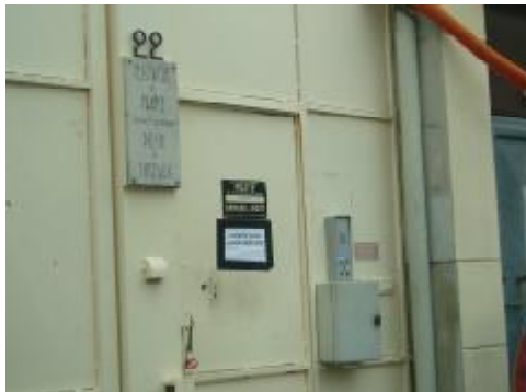
013 Puteaux 變電所人員入口
