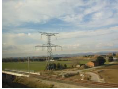
066 橫向配置輸電鐵塔(2 回線)1
