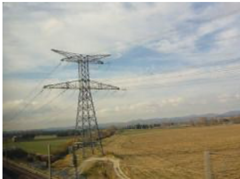
067 橫向配置輸電鐵塔(2 回線)2
