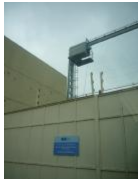
014 Puteaux 變電所大門
