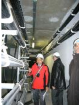
033 涵洞內電纜配置 3
