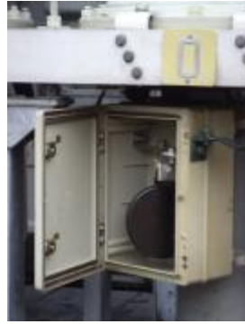
026 氣封終端舊型 SVL 配置
