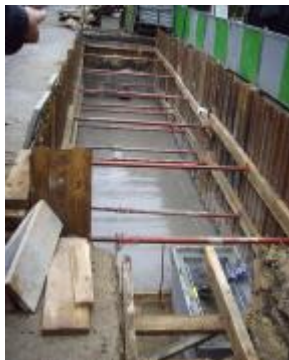
053 電纜管路接續人孔施工現場
