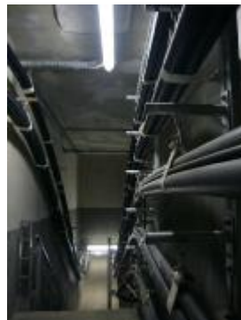
032 涵洞內電纜配置 2
