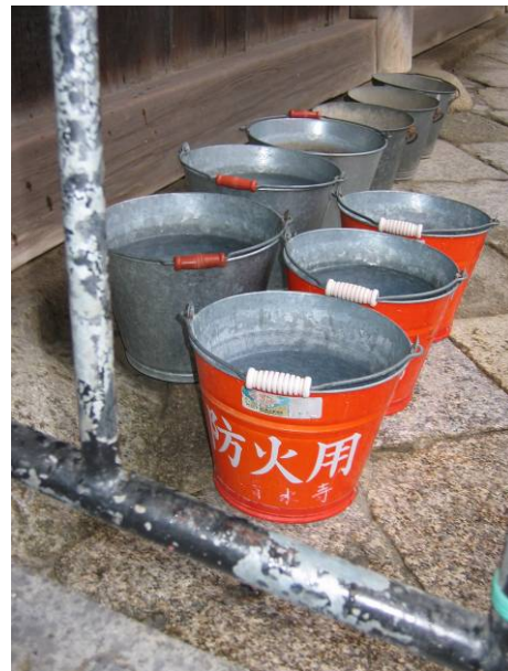
（下圖）陡峭狹小的入山道路不利於消防車進出，除了管制出入口交通，清水寺內建築牆基處每日也儲放數桶裝滿水的水桶，以供萬一火災發生時現場人員的初級救火用。
