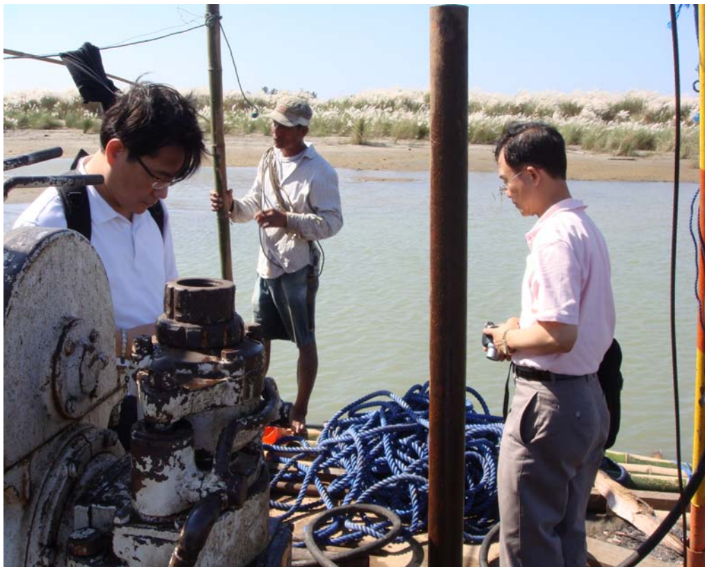
照片十二、Cagayan River河道中的工作平台
