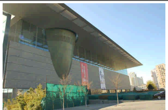
半裸露出外牆的圓形展示場
