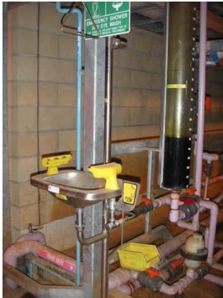
圖 31 氯化鐵加藥校正與緊急事故之淋洗器
