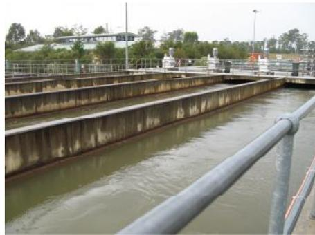
圖 28 長型膠凝接觸渠 2(contact channel)
