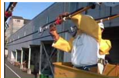
為使兩電線端頭不相觸，將一端固定。
