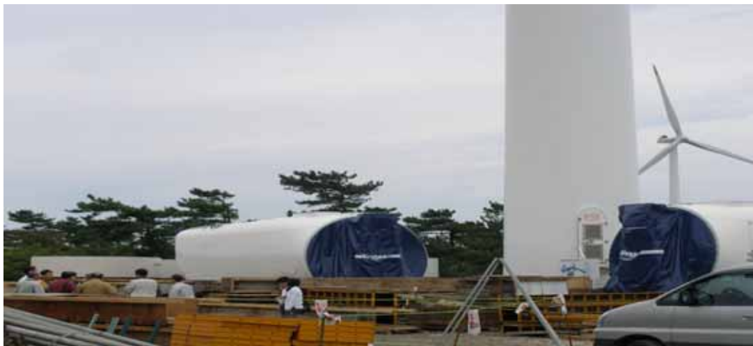
圖 14 正進行擴建風力發電機組設備
