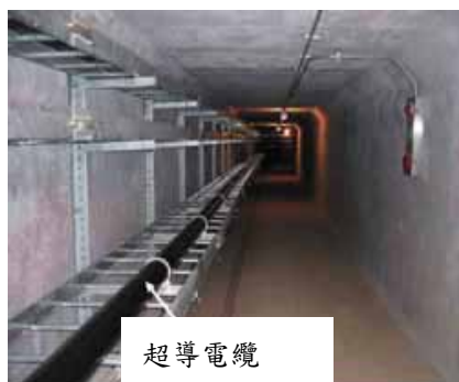
圖 19 洞倒內電纜敷設情況
