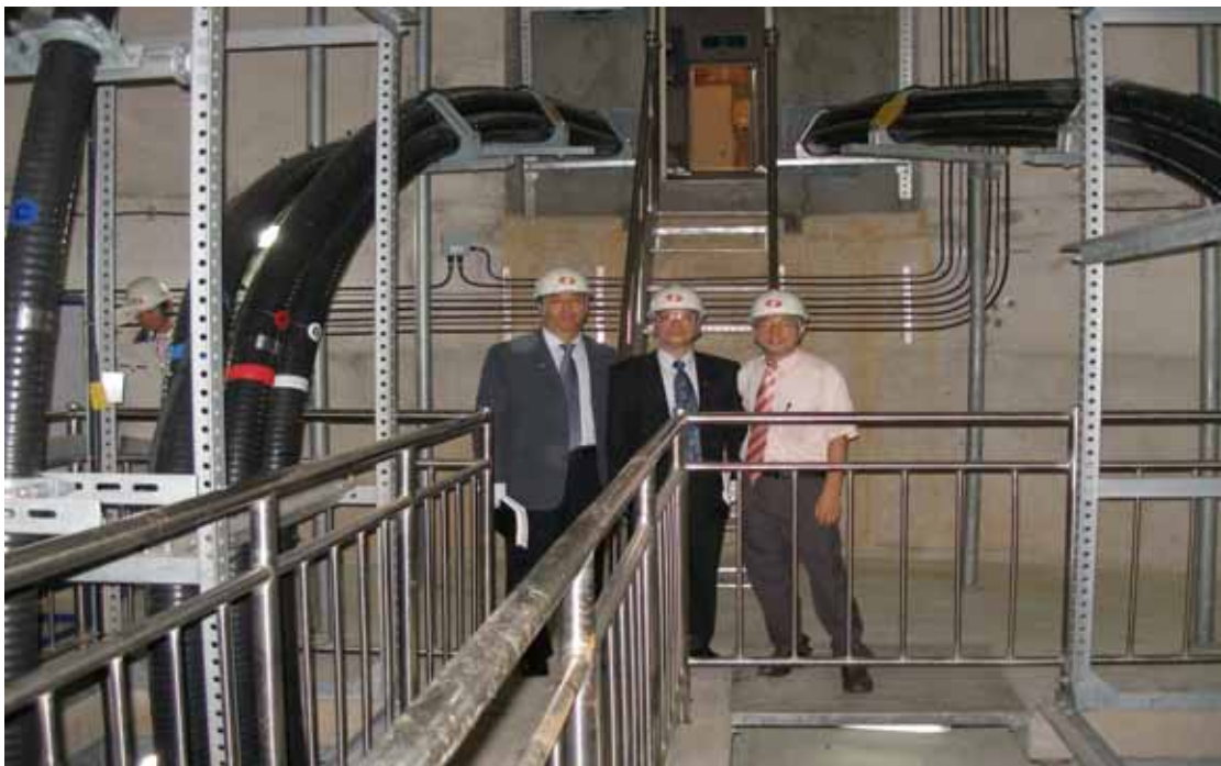
圖 4 進入電纜洞道需爬樓梯約 15 層
