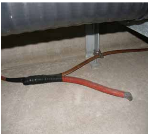
圖 8 潛盾洞道埋設接地銅棒做為接地用並未滲水
