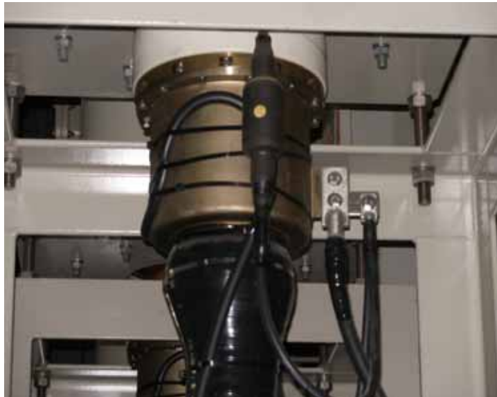
圖 13 新永浦變電所之氣封型電纜終端匣裝設 SVL
