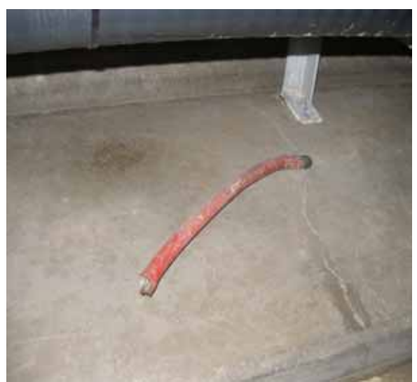
圖 8 潛盾洞道埋設接地銅棒做為接地用並未滲水
