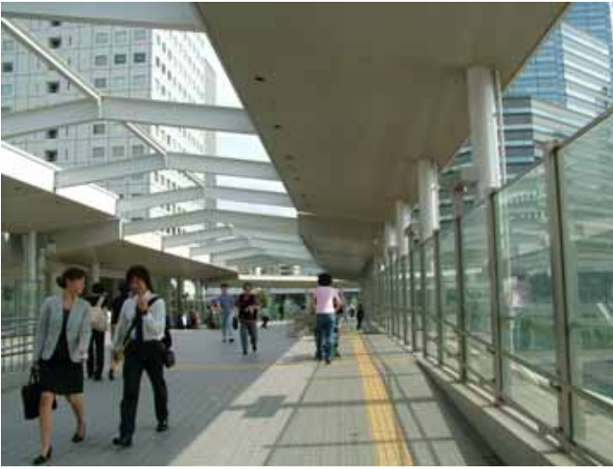
照片 3-5 大崎站東西自由通道跨站天橋
