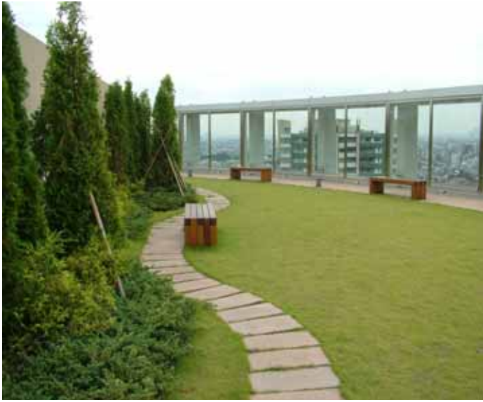
照片 3-9 出租住宅頂樓的空中花園， 步道等鋪面則採用透水性材料，為降 低熱島效應之對策之一
