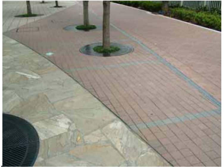
照片 3-10 大樓與目黑川間之步道鋪面亦採 透水性材質
