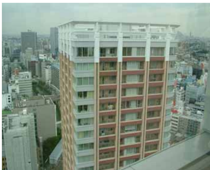
照片 3-13 出售住宅為地下 2 層、地上 27 層建築物
