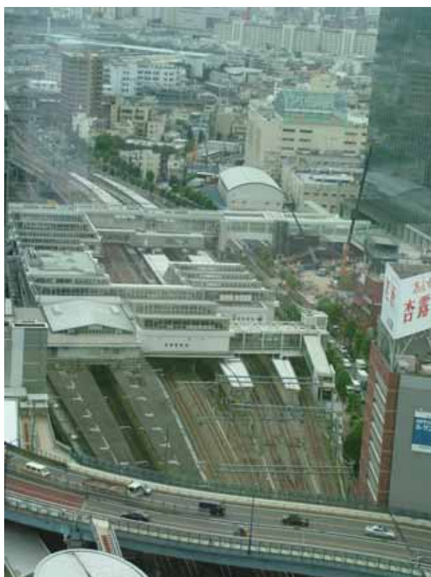
照片 3-3 從東口第三地區大樓上鳥瞰大崎站，可發現整個站區規模相當驚人，並有橫跨東西口的跨站天橋數座，而山手通橫貫於大崎站之前
