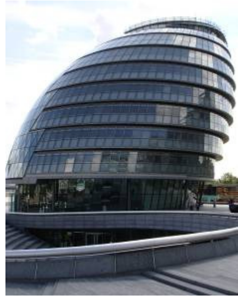
圖 16 倫敦新市政廳大樓外觀
